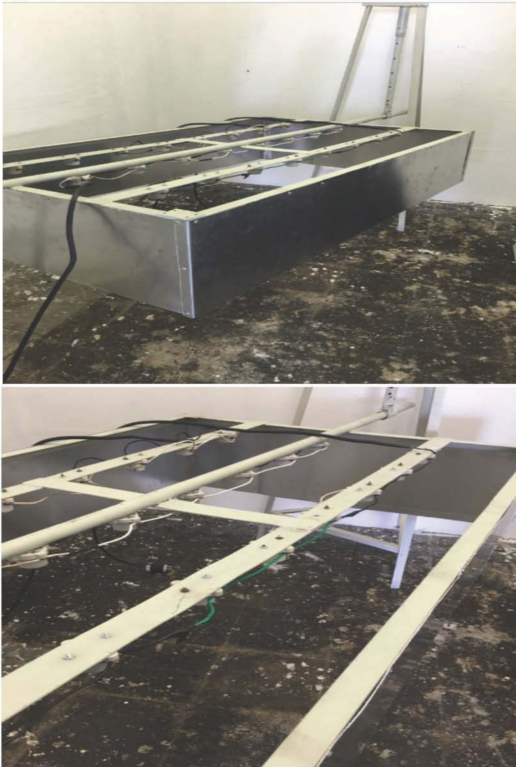
Fig. 34 Montaje de la estructura con concentrador solar
