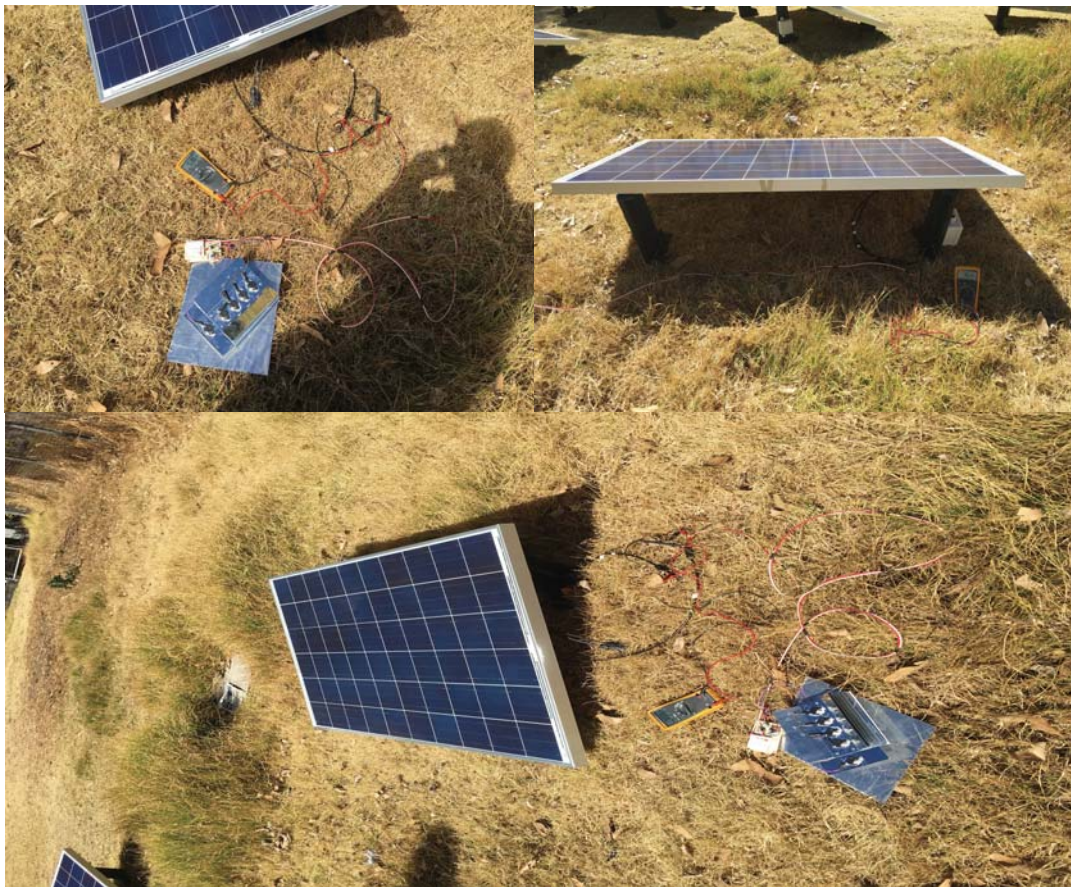
Fig. 40 Realización de pruebas a paneles fotovoltaicos
