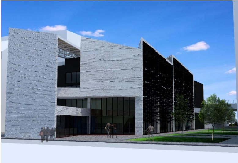
Fachada y acceso principal
