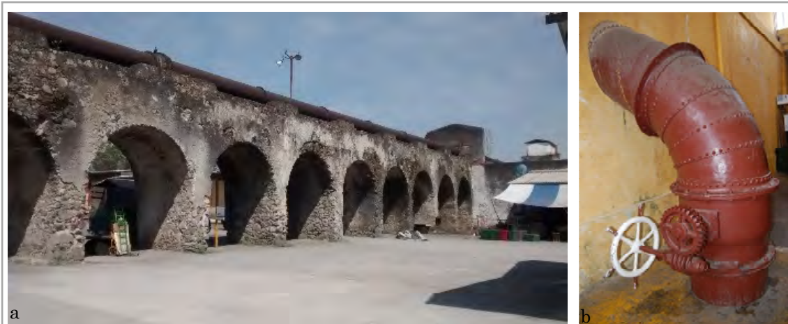
Ilustración 21. A diferencia de otras fábricas del conjunto que usan canales para alimentar las turbinas, la fábrica de Cerritos de San Juan captaba el agua desde el río Orizaba al norte por medio de un acueducto. Originalmente funcionaba a cielo abierto, posteriormente CIDOSA entubó el agua pero siguió utilizando los arcos como soporte. EPG 2016.
