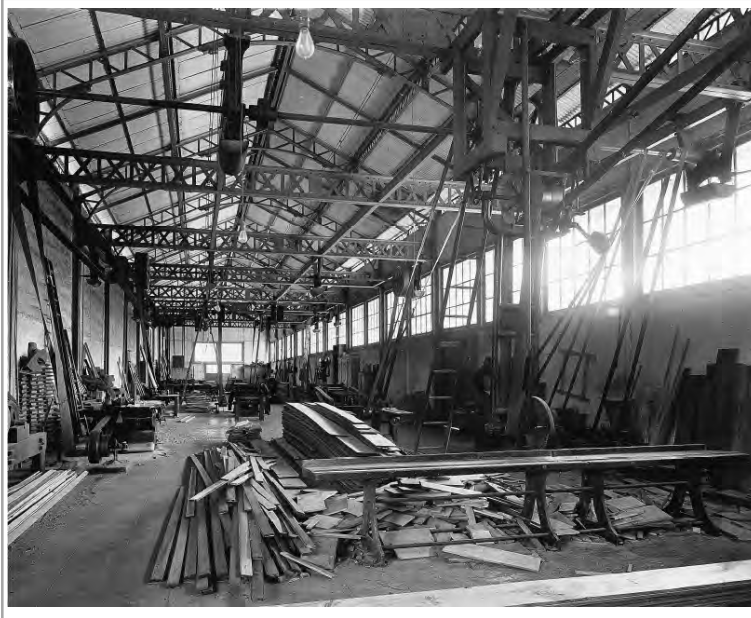
Ilustración 19. Estructura aparente de las naves industriales de Río Blanco y flechas de transmisión hacia 1905. (GARCÍA HOLLEY, 2013, p. 61).
