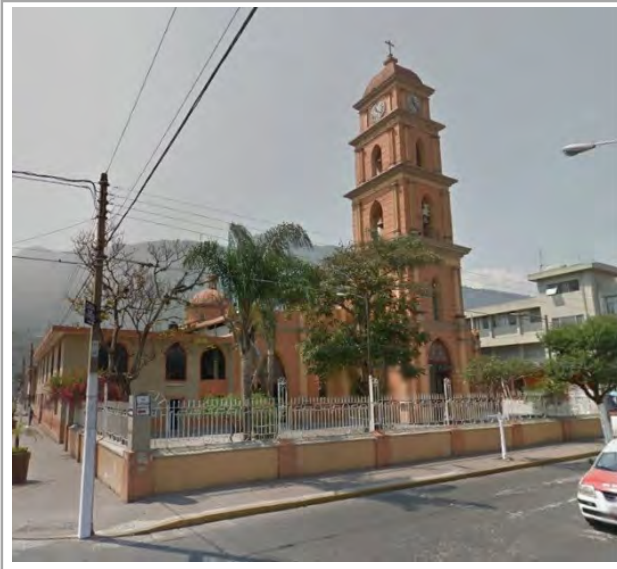
Ilustración 45. La planta baja de la torre campanario de la iglesia de Santa Rosa de Lima también funciona como da acceso a la nave de feligreses, algo muy similar a lo que ocurre en la torre campanario de la fábrica de Río Blanco que permite el acceso a la fábrica. Esta iglesia también ha sido ampliada en diversas ocasiones para recibir a un número mayor de asistentes. EPG 2014.
