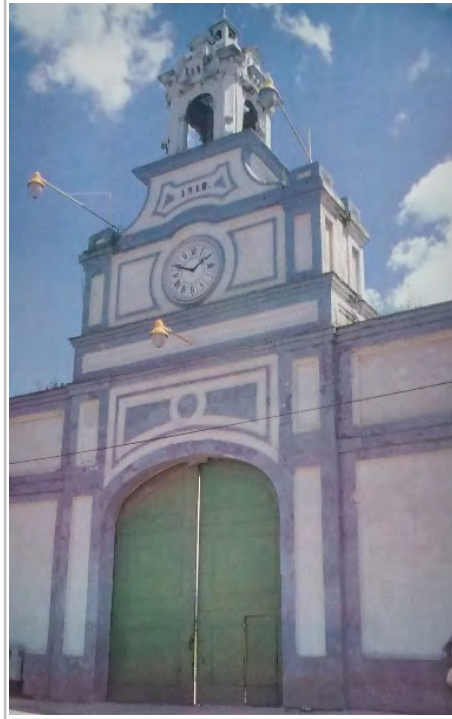
Ilustración 32. A partir de la remodelación integral de la fábrica de Cocolapan que tomo diez años, se construyó una portada en la entrada principal inspirada en la fábrica de Río Blanco. También funcionaba para el acceso del tren en ambos sentidos, para el ingreso de las materias primas y para los productos terminados. Fuente: foto en (EVERAERT, 1990, p. 89).
