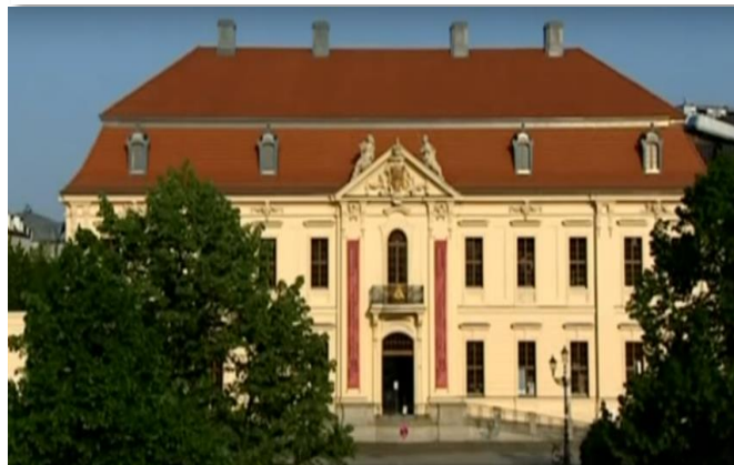
Foto 1: Kollegienhausm una construcción del siglo XVIII, sede de la Corte Suprema del Reino de Prusia. Edificio aledaño al Museo Judío de Berlín.
