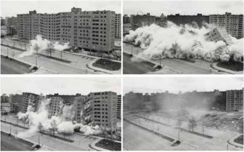
Demolición del complejo habitacional Pruitt-Igoe 1972 St. Louis, Missouri
