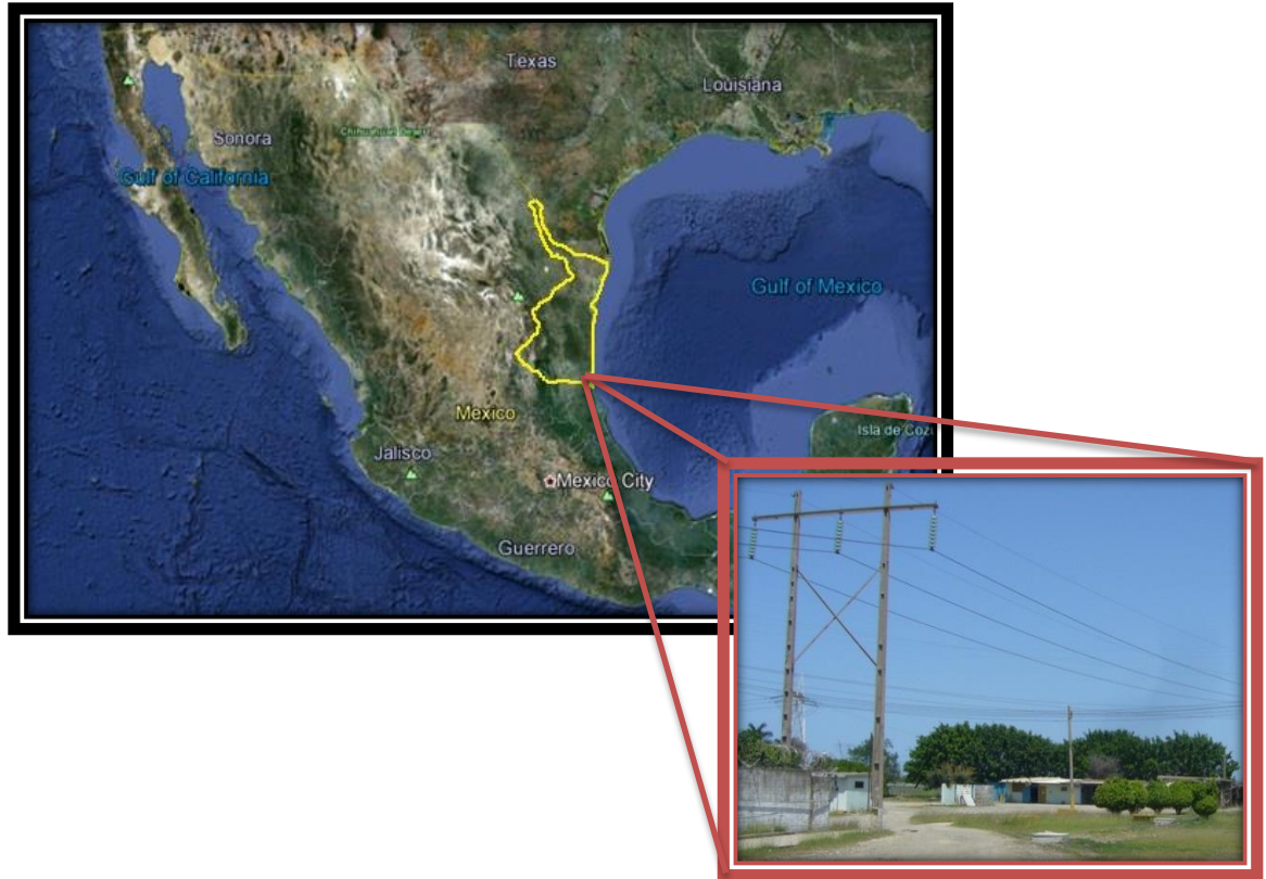
Figura 1.- Ubicación del predio donde se desplantara el Edificio Técnico-Administrativo en la Central de Altamira de la C.F.E.
