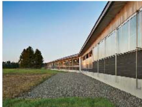
La forma apretada del establo aprovecha del flujo del viento y ayuda con ventilación y control de la temperatura. Cortinas de tela de nylon pueden encerrar el establo en el invierno, mientras que la sala de ordeña (primer plano) tiene paneles de policarbonato operable.
