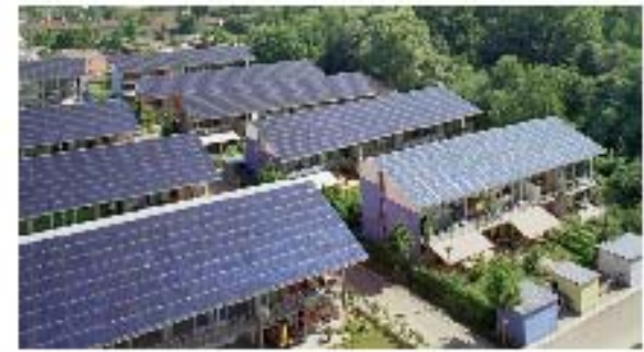
Cubiertas con Paneles Solares Alemania, techos de edificios y negocios.
