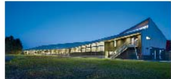
Fachada exterior del Establo
