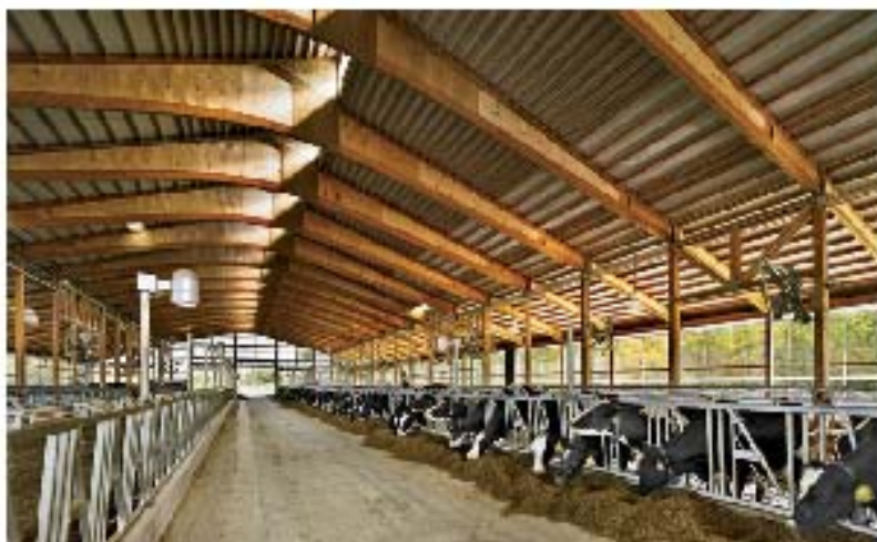
Cerchas de madera laminada en armaduras evitan la entrada de aves y reduce al mínimo la propagación de enfermedades; las vacas son libres de comer cuando les plazca.
