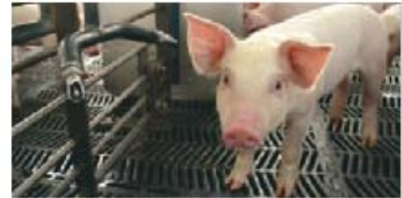
Primera Etapa de Tratamiento de Aguas - Piso Ranurado
