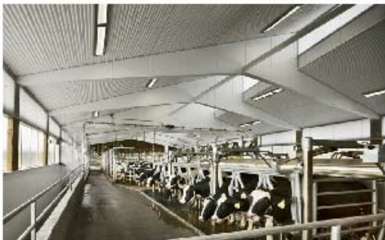
Un sistema de policarbonato en la sala de ordeña imita a su contraparte del establo, pero puede ser lavado, un requisito de saneamiento. Las vacas son ordeñadas mecánicamente tres veces al día, 20 a la vez; el proceso para limpieza de instalación dura tres horas.
