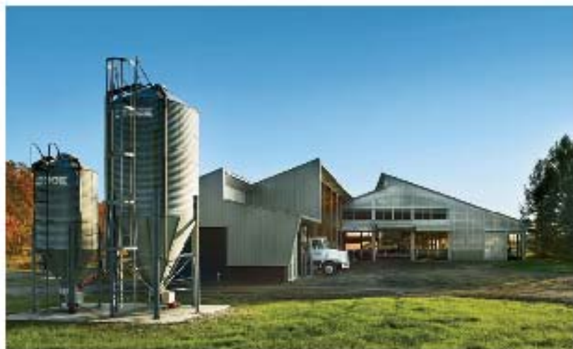
Un ala de almacenamiento de alimentación se conecta a la parte posterior del establo.
