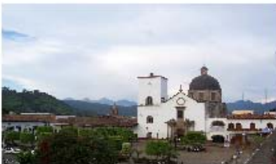
El Templo del Hospital Construido por Don Vasco de Quiroga
