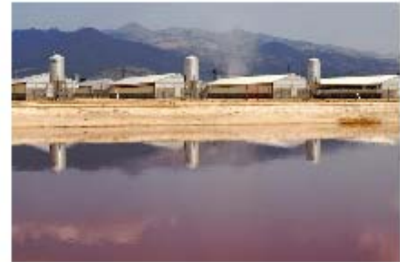
Aspecto exterior de las granjas, diseño simple y funcional. Carece de diseño Arquitectónico.
