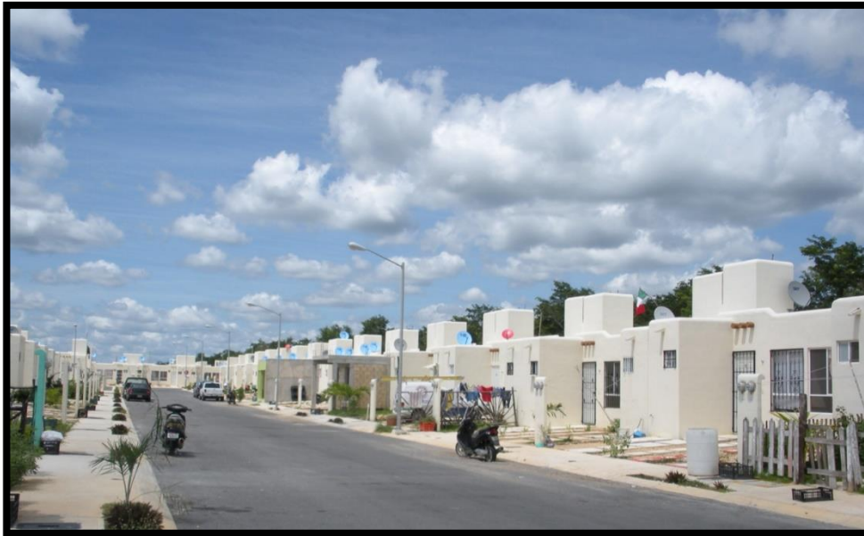
Fotografía Rosalia Camacho Lomelí, octubre 2011
