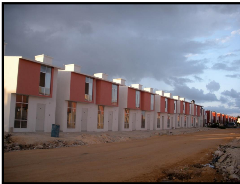
Imagen 4. 8 Casas en construcción en Desarrollo Habitacional Puerto Maya en Ciudad Aventuras
