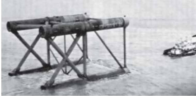
Figura 1.10 Subestructura para una plataforma tipo torre
