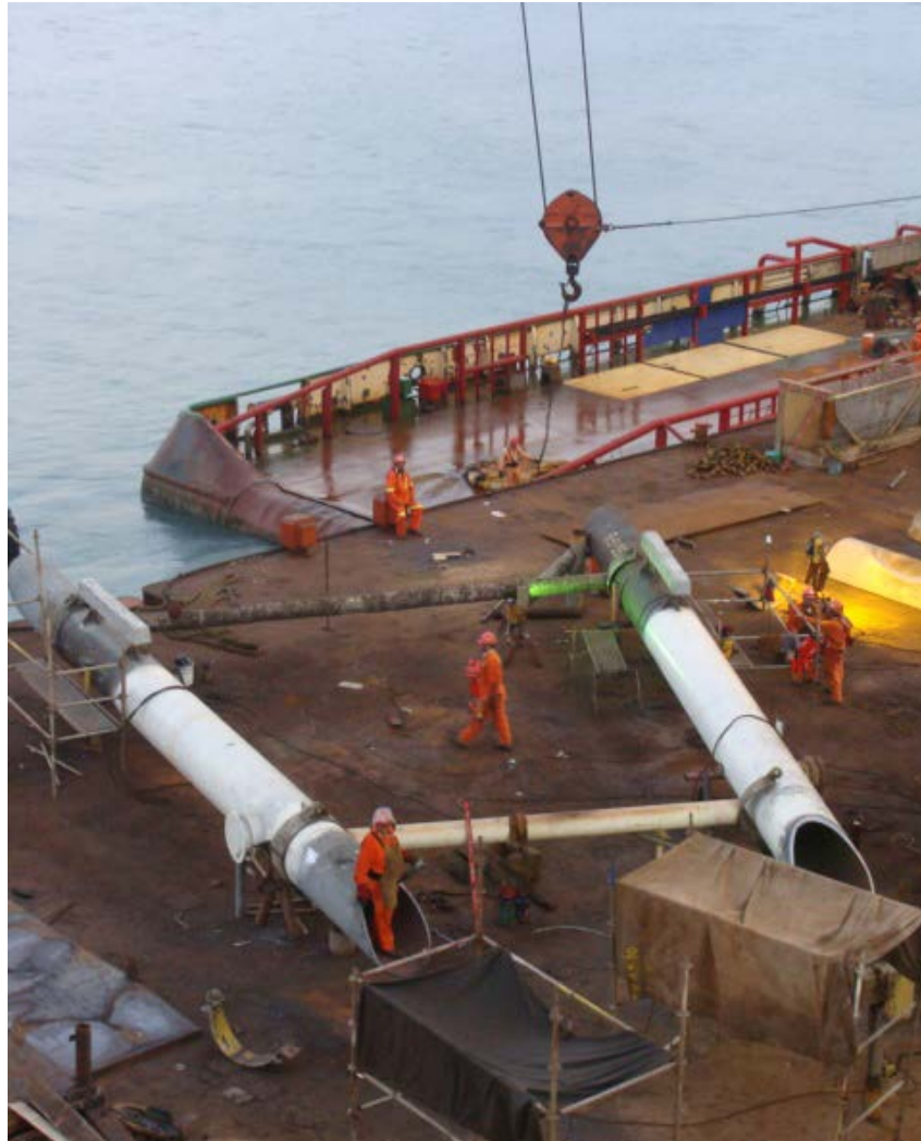
Figura 2.2 Fabricación de marco para subestructura
