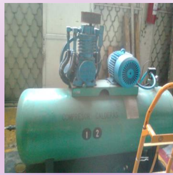
COMPRESOR DE CALDERAS IMAGEN OBTENIDA DEL HOSPITAL REGIONAL ISSSTE ADOLFO LÓPEZ MATEOS
