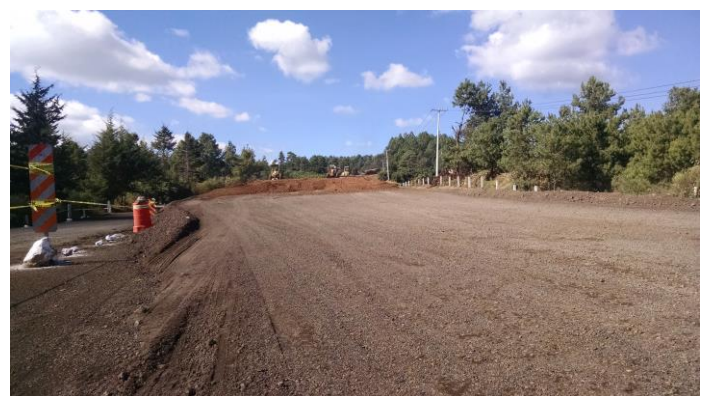
Sub-base conformada
