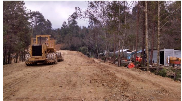
Compactación de subrasante
