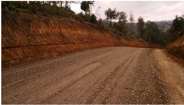
Base hidráulica conformada
