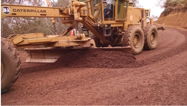
Extendido con Motoconformadora
