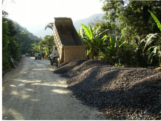
Fig. 4.2 Tendido de material
