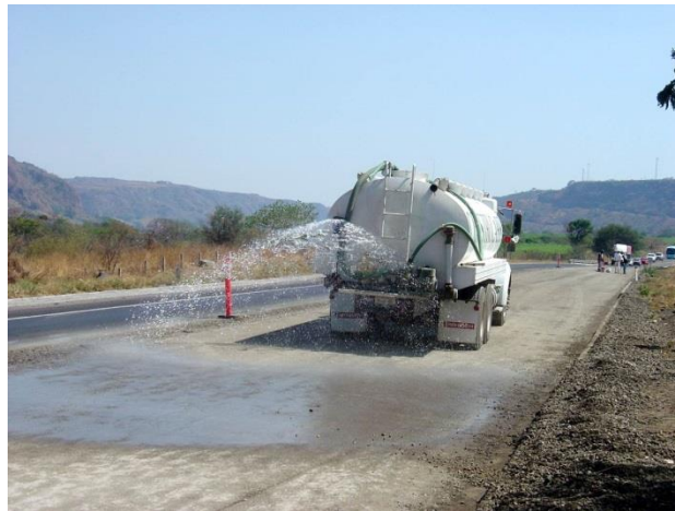
Fig. 4.3 Riego con pipa
