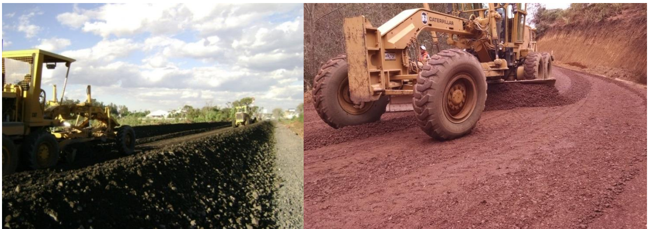
Fig. 4.4 Extendido de material con motoconformadora
