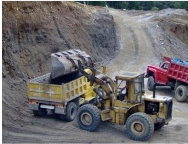
Fig. 4.1 Carga de material con retroexcavadora.
