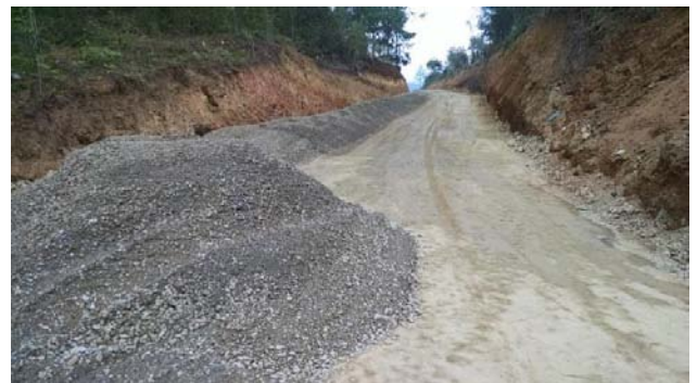
Tendido de material de base
