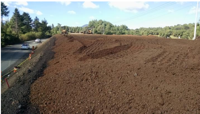
Extendido de base
