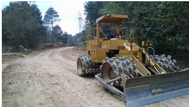
Compactación de subrasante
