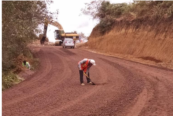
Fig. 4.5 Descubierta de trompos
