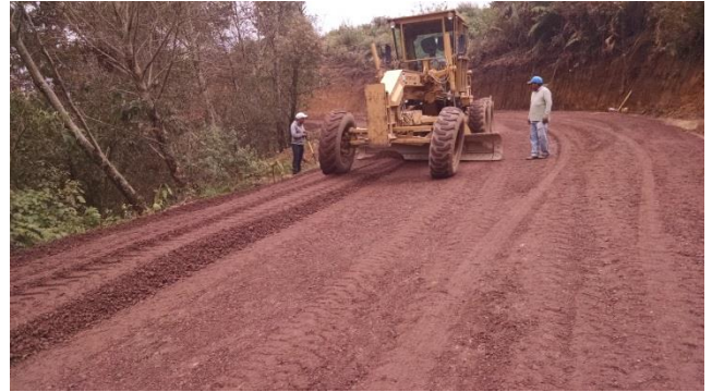
Afine de bombeo con Motoconformadora
