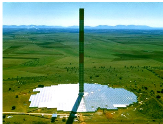
Figura 7 Torre de energía.
