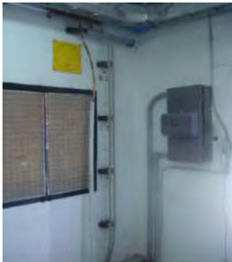
Figura 4.32 Separación en la instalación de aisladores en el cable vertical.
