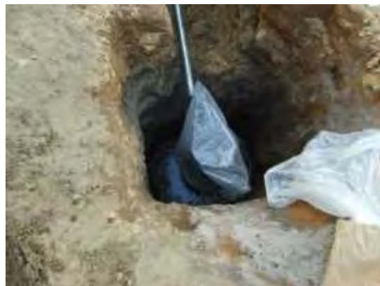
Figura 4.10 acondicionador de tierras EP-TR
