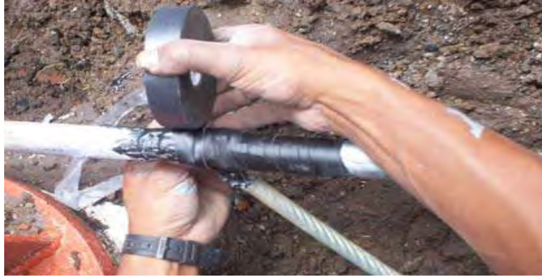
Figura 4.22 Aislamiento del cable y el tubo galvanizado.
