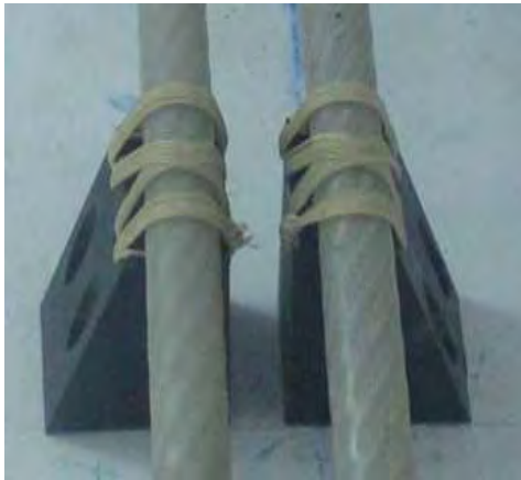
Figura 4.31 Instalación del cable vertical.
