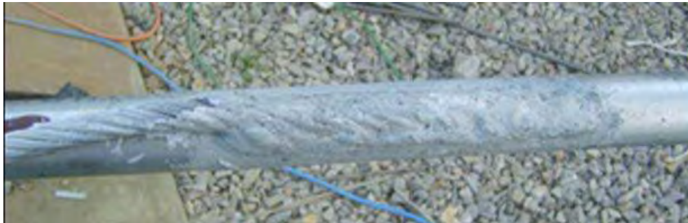
Figura 4.20 Aplicación del galvanizado en frío a la soldadura cable tubo galvanizado
