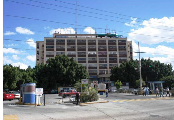
Antigua Central de Autobuses de Guadalajara, Jalisco. Fuente: Google Imágenes 2015.
