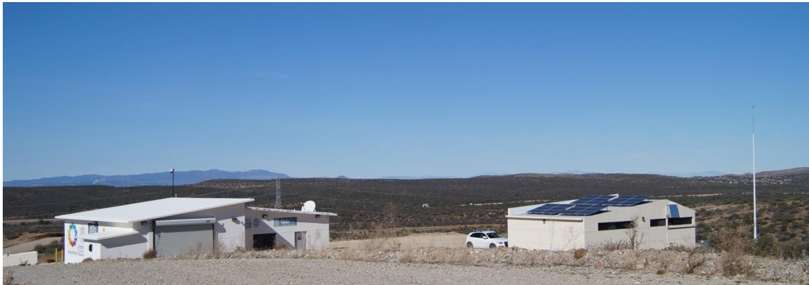
Figura 4.2. Navarro, E., Instalaciones de control del Parque Eólico “La Rumorosa 1”, La Rumorosa, diciembre de 2013
