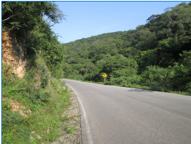
Fig. 18 . Carretera presente en la localidad de Tecuiziapa.
