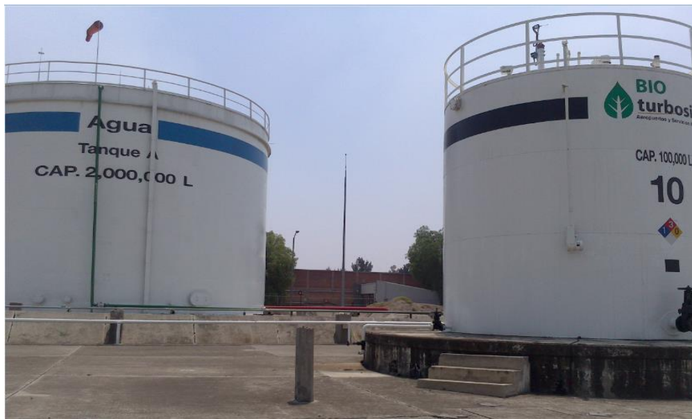
Figura 5.12. Tanque en instalaciones de ASA. Un avion comercial tipo 747 jumbo tiene capacidad para este tanque de 100 000 litros.
