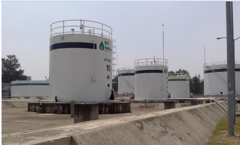
Figura 5.11. En esta imagen se observan los tanques de bioturbosina o combustible organico que se utilizarán para mezclar con el combustible fosil.Dichos tanques se encuentran al fondo de esta imagen.
