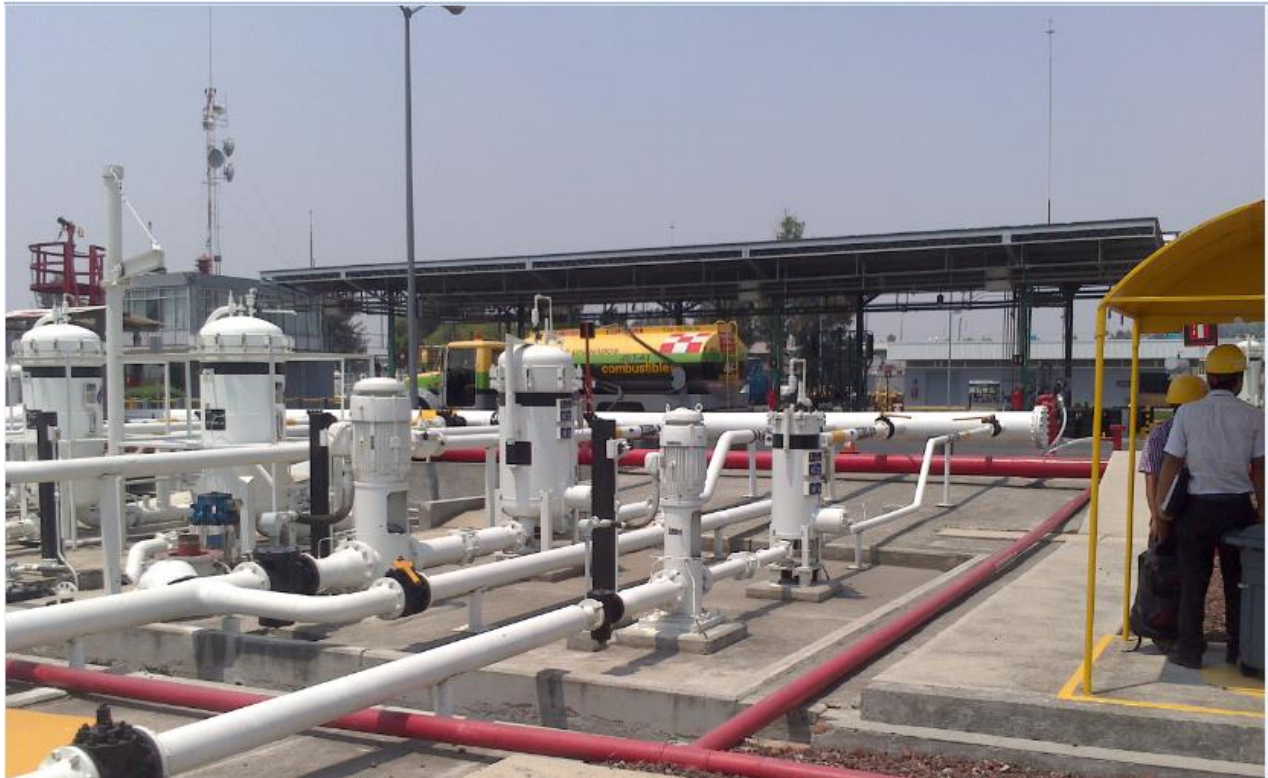
Figura 5.13. Instalaciones de ASA. En la extrema derecha de la imagen se colocará la caseta de vigilancia del sistema mezclador de combustibles.
