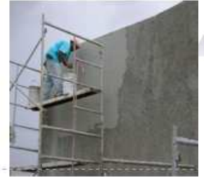
Aplanados de concreto
