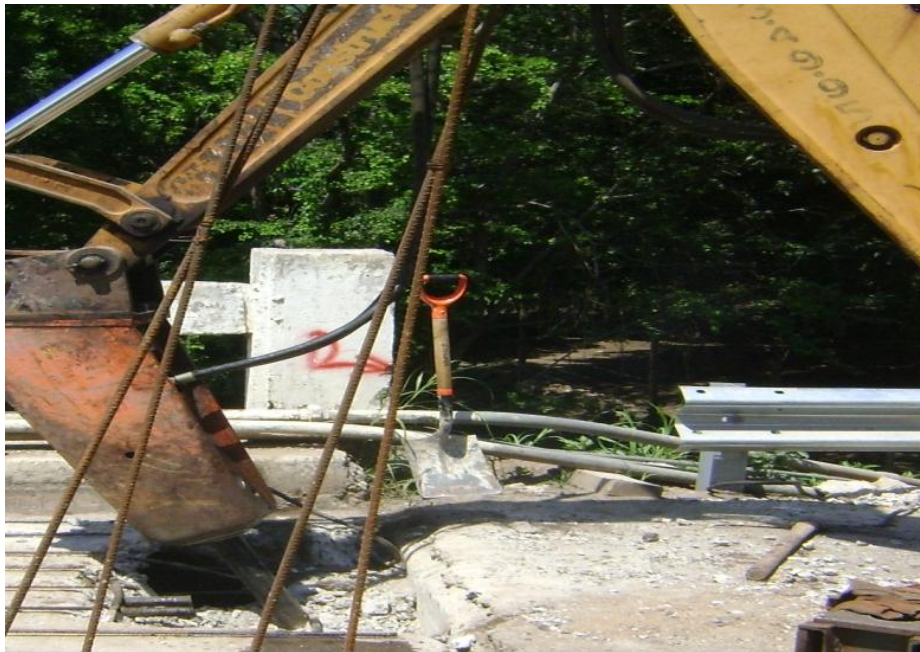
Imagen: 5.4. Demolición por medio de rotomartillo para ventanas de colado.
