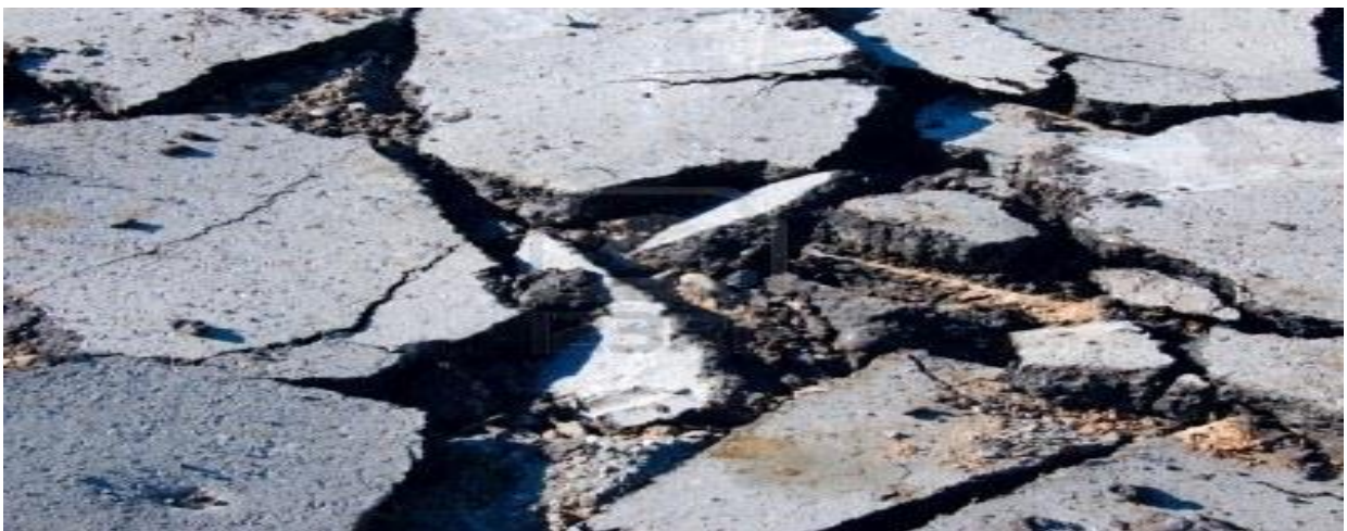
Imagen: 5.9. Demolición de carpeta asfáltica.
