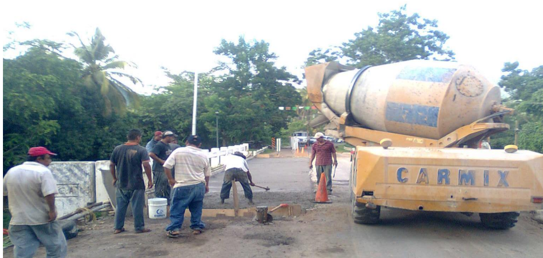
Imagen: 5.11. Colado de sobrelosa.
