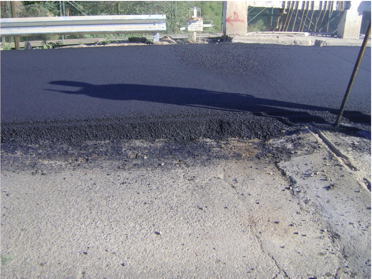
Imágenes: 5.17. Colocación de carpeta asfáltica.
