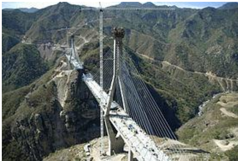
Imagen: 1.2. Puente Baluarte Bicentenario.
