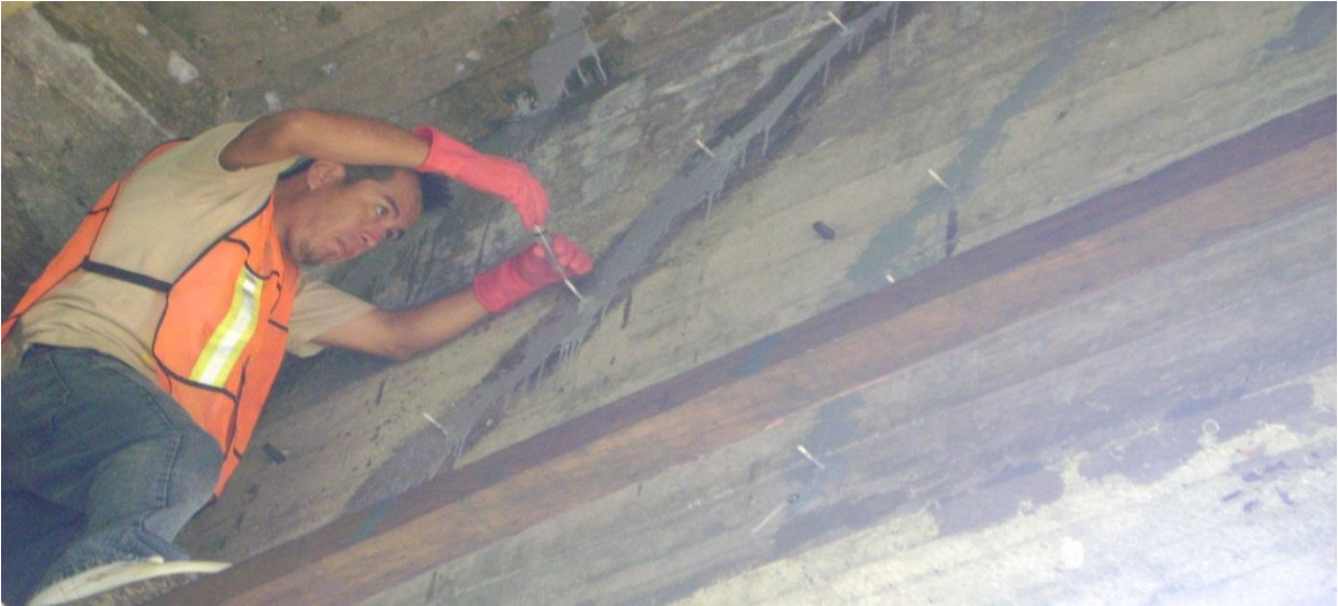
Imagen: 5.2. Reparación de grietas y fisuras en trabes y diafragmas.
