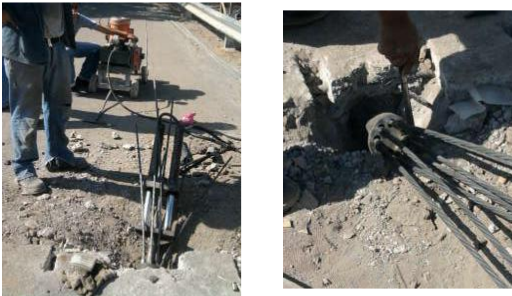
Imagen: 5.15. Momento en que se realiza el postensado.
