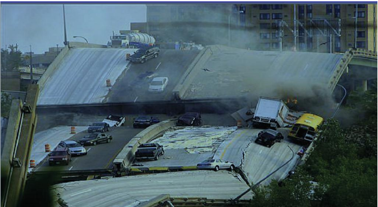
Imagen: 2.7. Puente Mississippi colapsado por falta de mantenimiento, rehabilitación y reforzamiento de partes dañadas.
