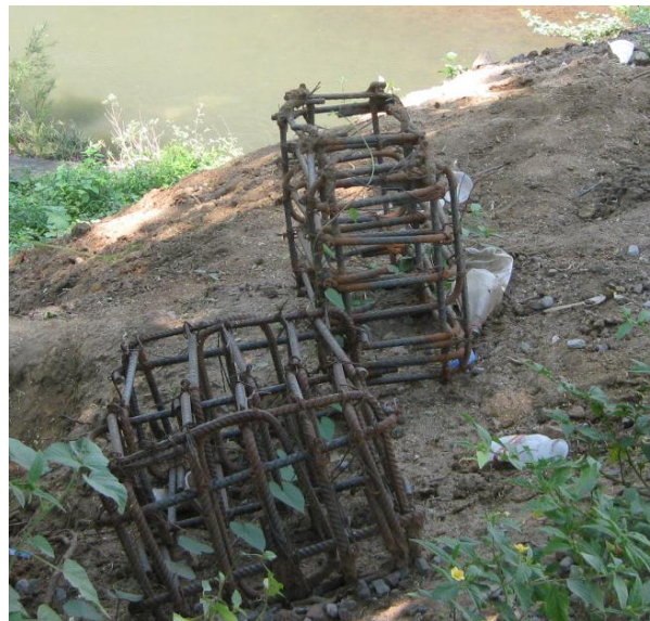
Imagen: 5.5. Bloques de anclaje hechos en obra.
