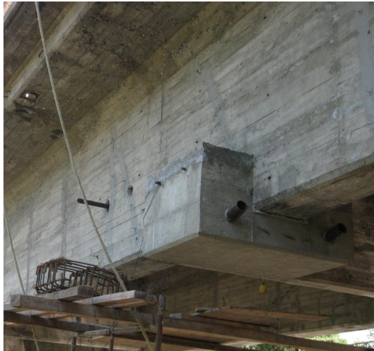
Imagen: 5.6. Bloques desviadores terminados.
