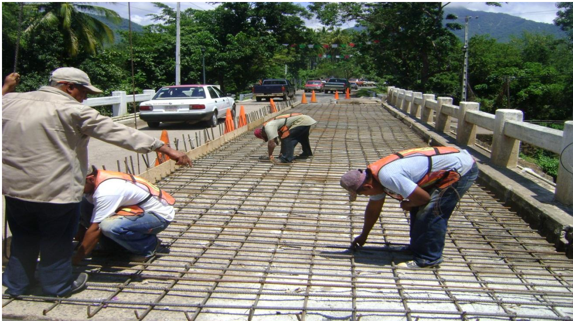
Imagen: 5.10. Armado de sobrelosa, de un sólo carril para no detener el tráfico.
