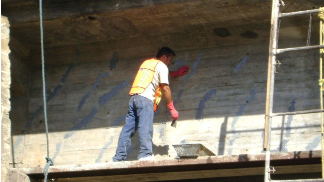
Imagen: 5.3. Resane de apanalamientos y acero expuesto del puente.
