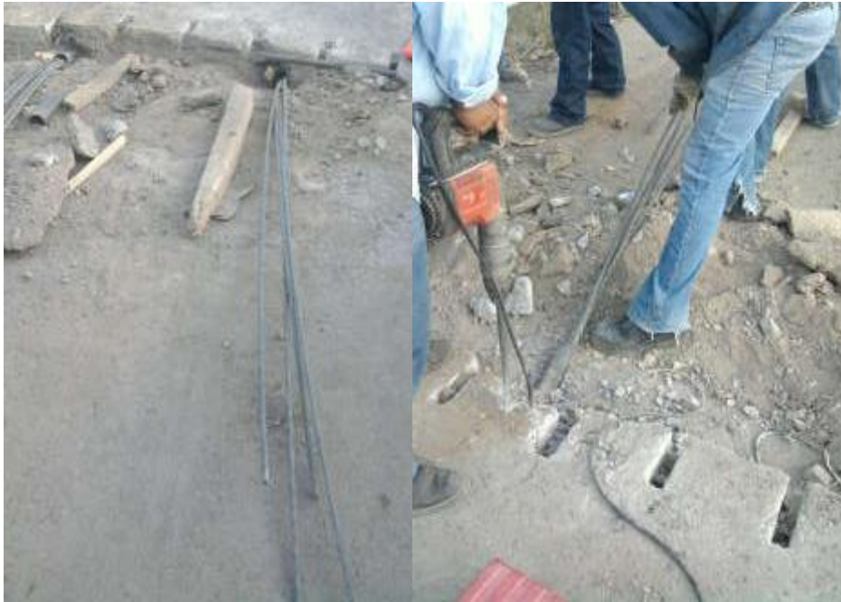
Imagen: 5.14. Colocación de torones para postensado.
