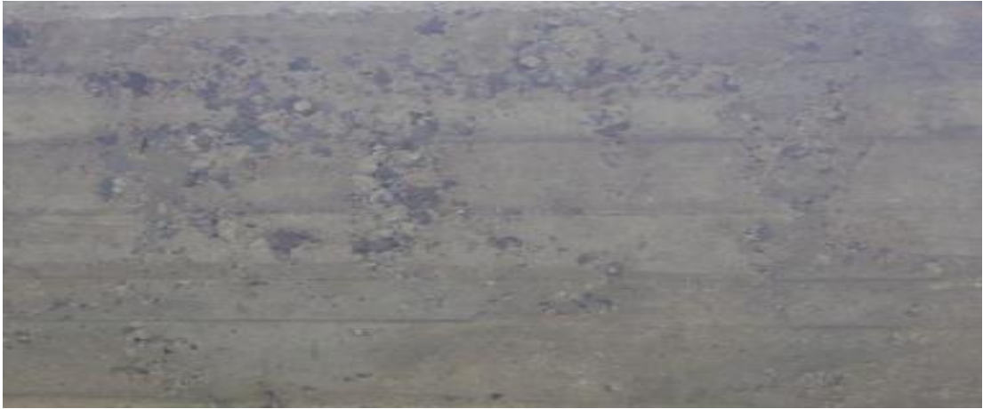
Imagen: 2.2. Puente La Huacana II, losa con apanalamiento.
