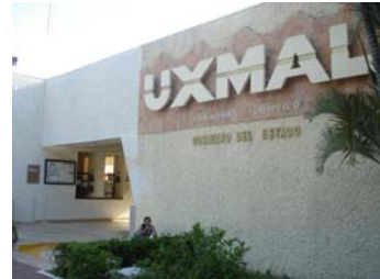
Vista del acceso
