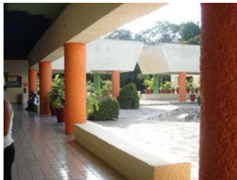
Vista del límite del patio
