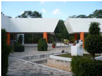
Vista del patio y acceso a Z.A.
