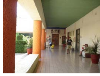
Pasillo o pórtico N
