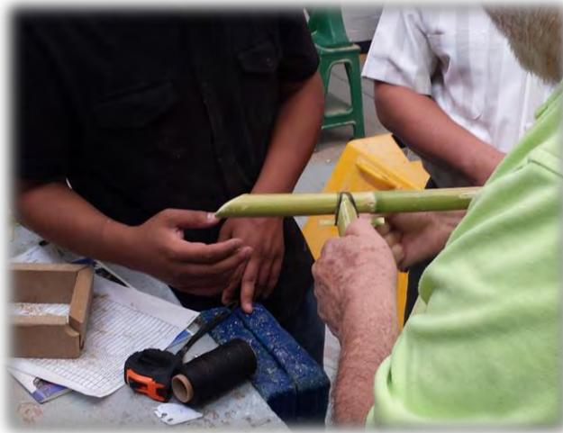
Figura 5.6.- Ensamble con hilo cubierto de chapopote.
