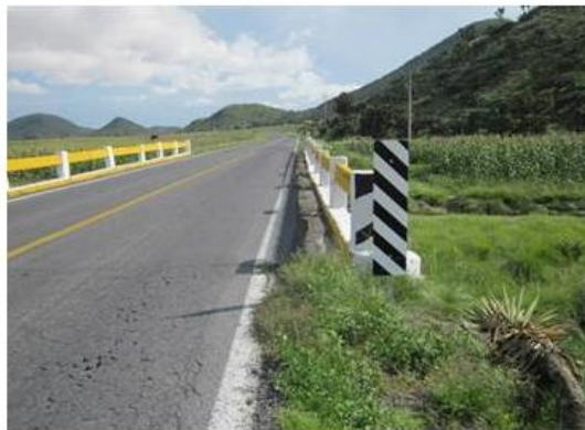
PARAPETO LADO AGUAS ARRIBA.
