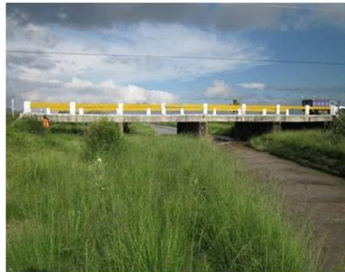
VISTA GENERAL DEL PUENTE, LADO AGUAS ARRIBA.
