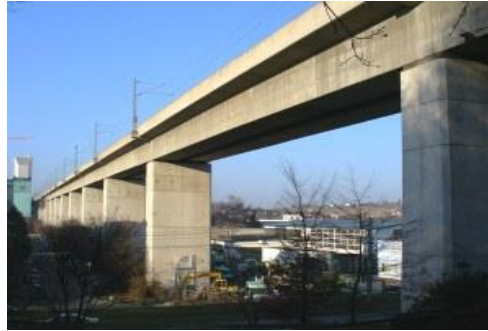
Fig. 1-7 Puente de Viga (Ref.: Wikipedia.org)
