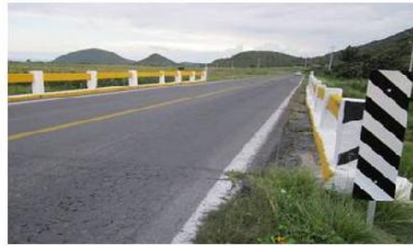
VISTA SOBRE LA ALZADA DEL PUENTE, LADO PUEBLA
