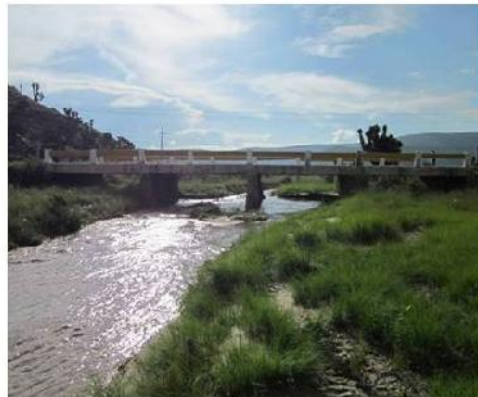
VISTA GENERAL DEL PUENTE, LADO AGUAS ABAJO.
