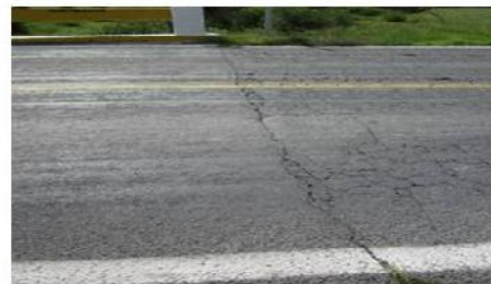
TRAMO 4-5, DESDE LADO AGUAS ARRIBA JUNTA DE CALZADA
