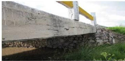
TRAMO 1-2, LADO AGUAS ABAJO
