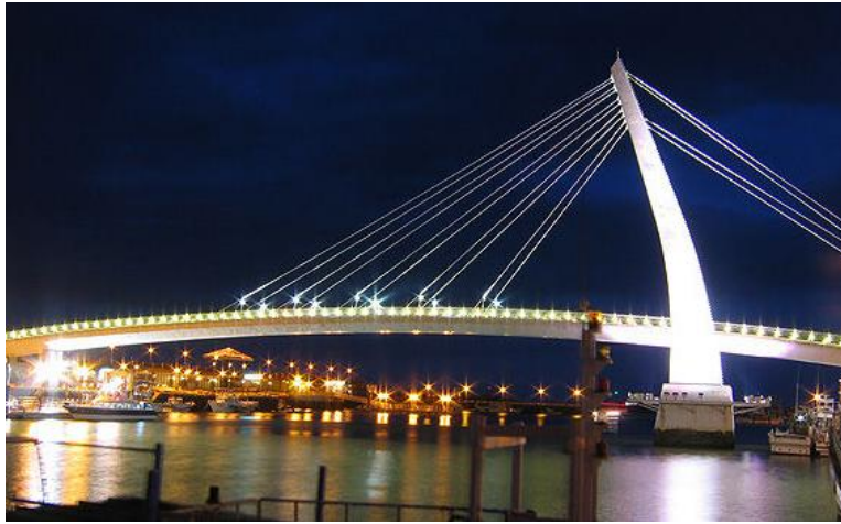
Fig. 1-11 Puente Atirantado (Ref.: Wikipedia.org)
