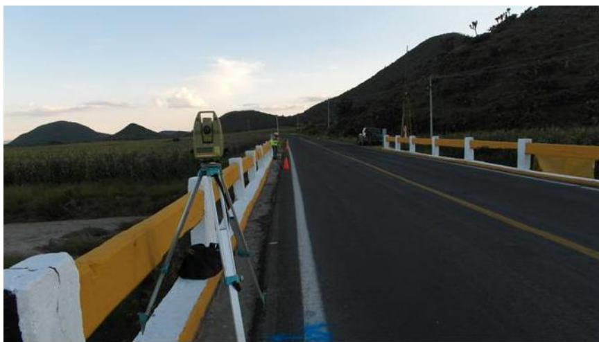
Fig. 2-4 Levantamiento "Puente Oriental" vista a Puebla
