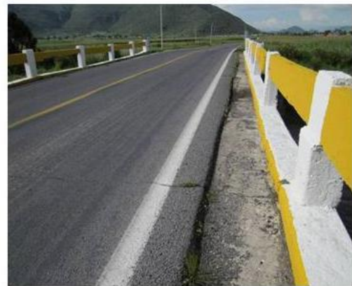
VISTA SOBRE LA CALZADA, LADO TEZUITLAN.
