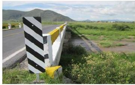
VISTA SOBRE CALZADA, PARAPETO LADO AGUAS ABAJO.
