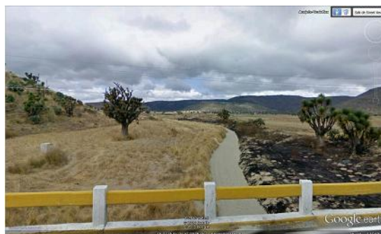
Fig. 2-23 Vista del cauce hacia aguas arriba (Ref.: Google earth)
