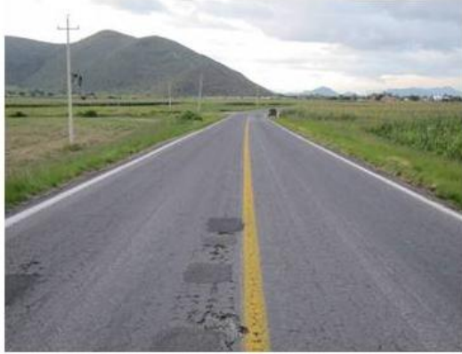
ACCESO AL PUENTE, LADO PUEBLA.
