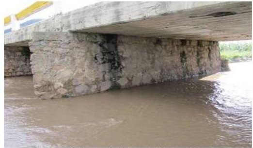
PILA EJE 3, LADO PILA EJE 2
