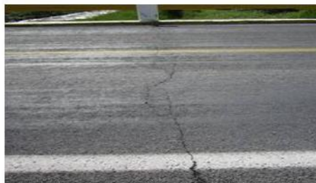
TRAMO 3-4, DESDE LADO AGUAS ARRIBA JUNTA DE CALZADA EJE 4.
