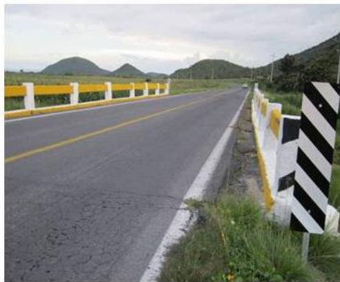
VISTA SOBRE LA CALZADA DEL PUENTE, DESDE LADO PUEBLA.
