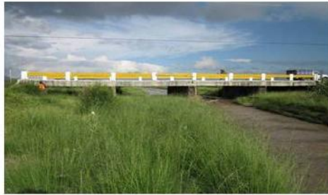
VISTA GENERAL DEL PUENTE, LADO AGUAS ARRIBA
