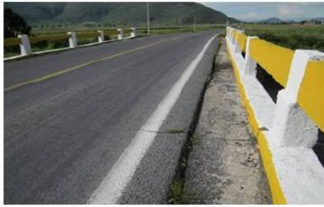
VISTA SOBRE LA CALZADA, LADO TEZUITLAN
