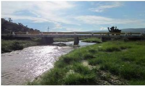
VISTA GENERAL DEL PUENTE, LADO AGUAS ABAJO
