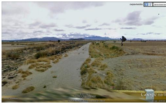
Fig. 2-24 Vista del cauce aguas abajo (Ref.: Google earth)
