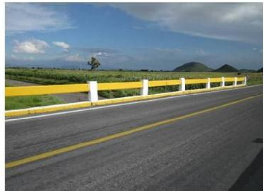
PARAPETO LADO AGUAS ARRIBA.
