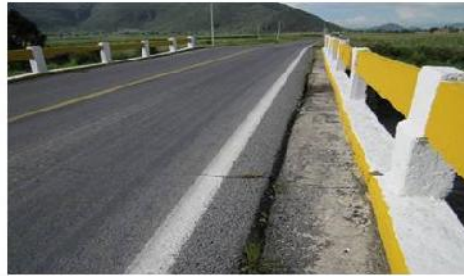
VISTA SOBRE LA ALZADA DEL PUENTE, LADO TEZIUTLÁN
