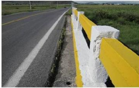
TRAMO 2-3, LADO AGUAS ABAJO PARAPETO DE CONCRETO REFORZADO.
