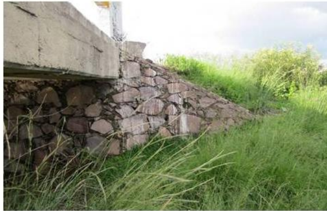
ESTRIBO EJE 1, ALERO AGUAS ABAJO.
