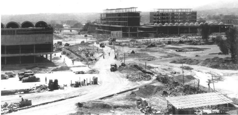
Figura 1.3. Escuela Nacional de Ingenieros en plena construcción
