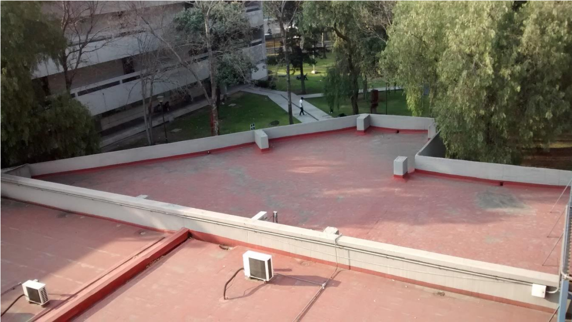
Figura 2.2. Vista desde la Torre del Edificio I
