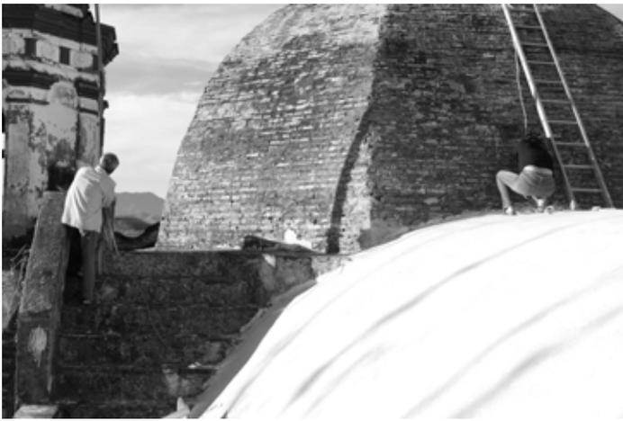
Fig. 9 Levantamiento de la altura de cúpula octogonal KFF, 2012
