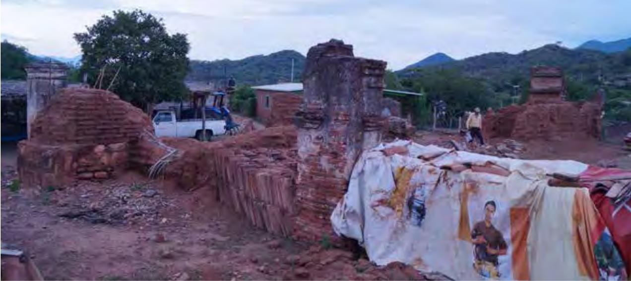
Fig. 33 Restos en la fachada poniente, contrafuerte de piedra y adobe, con pilastra del pórtico . KFF, 2013
