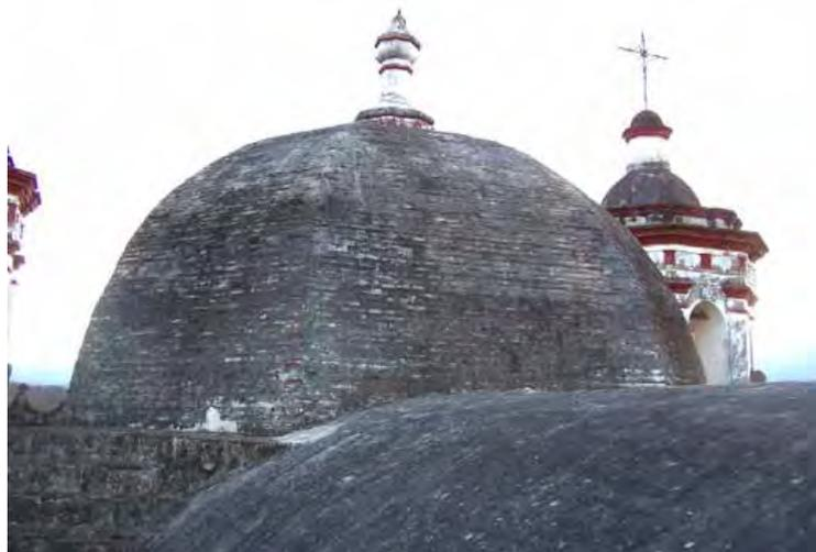
Fig. 22 Perdida de aplanado por incuria sobre la cúpula octagonal sobre el coro, donde la fabrica de ladrillo puede ser observada. KFF, 2012
