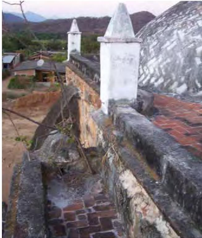
Fig. 25 Crecimiento de flora parasitaria y obstrucción de bajada de aguas pluviales en transepto. KFF, 2012
