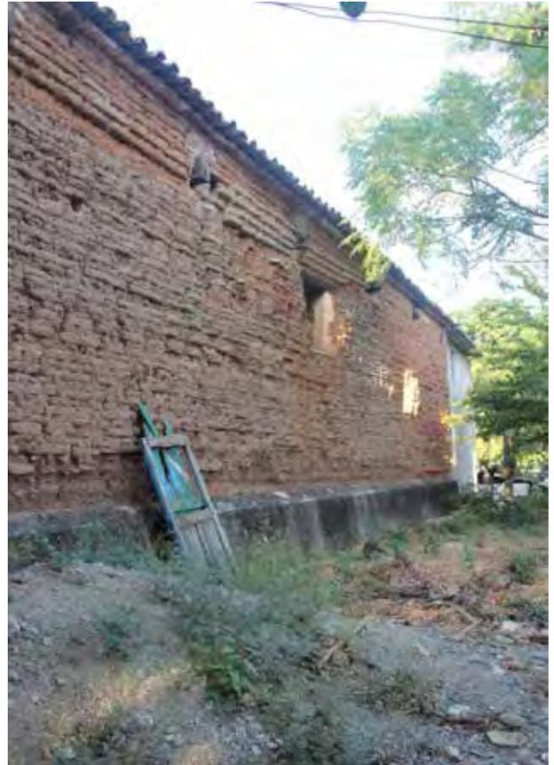
Fig. 117 Ermita en San Pedro Huamelula, donde se ve e sistema constructivo con adobe y cubierta con teja. KFF, 2014
