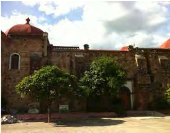
Fig. 105 Vista de la fachada sur, donde se encuentra la puerta lateral, los contrafuertes predominan en la fachada y en el espacio que ocupa el coro predomina la fabrica con tabique rojo. KFF, 2013
