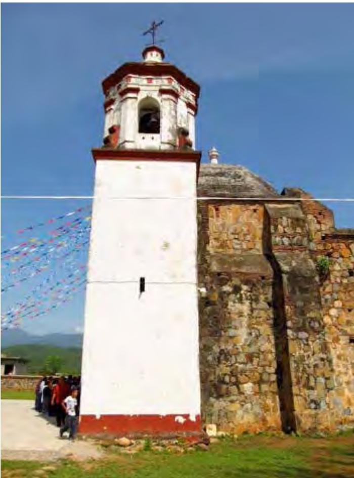
Fig. 7 Vista lateral de la torre oriente. Donde se perciben el cambio de materiales entre elementos constructivos, así como las diferencias en los planos estructurales. KFF, 2012
