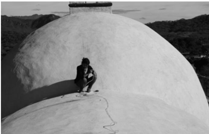
Fig. 10 Levantamiento arquitectónico de techos. Nivel y dimensiones de la bóveda. KFF, 2012.
