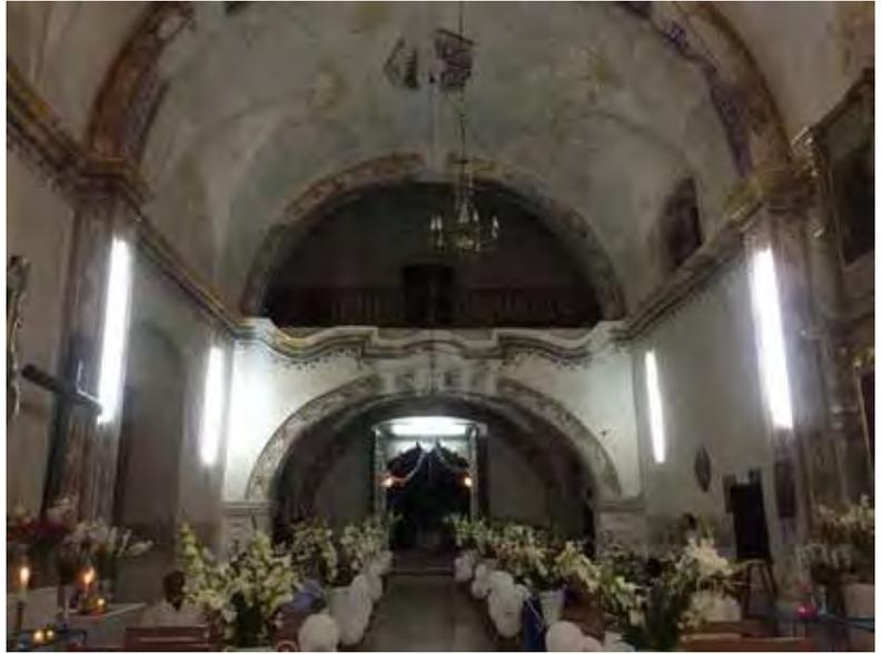
Fig. 120 Vista del coro y sotocoro. En la foto se ve una bóveda de cañón corrido con lunetos y arcos formeros. KFF, 2014
