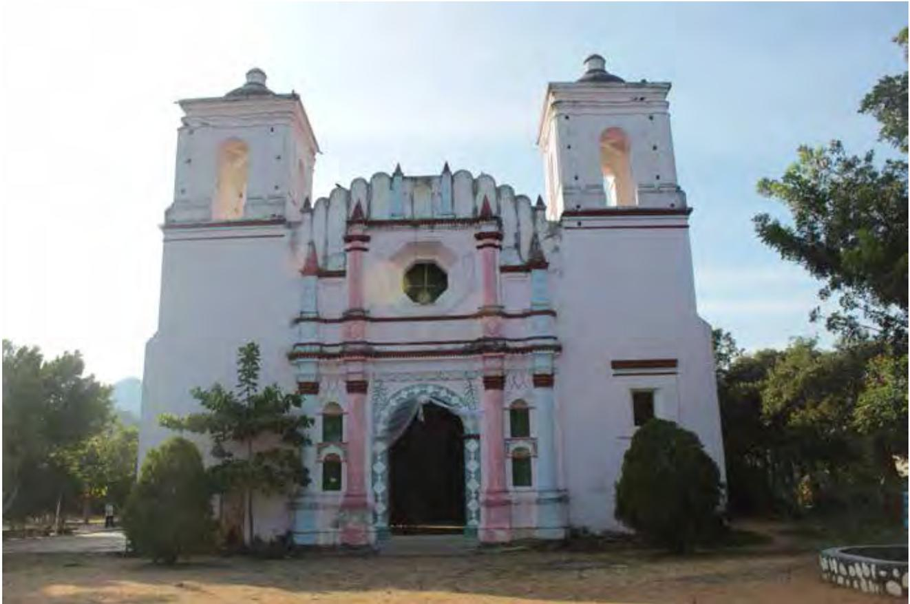
Fig. 108 Vista de la fachada principal en de la iglesia en San Pedro Huamelula. Tiende más a un cuadrado, pero la composición es consistente con Tlacolulita, con cuerpo central flanqueado con dos torres campanario, puerta de acceso con arco de medio punto, oculo en el coro y remate. KFF, 2014
