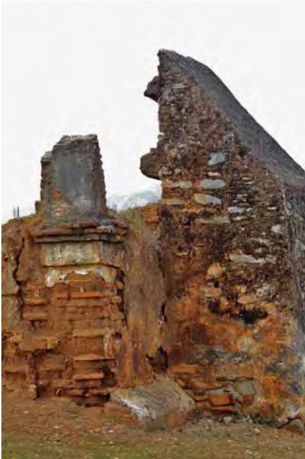
Fig. 30 Contrafuerte oriente en el cuerpo principal, muros de adobe y restos de aplanados de cal. KFF, 2013
