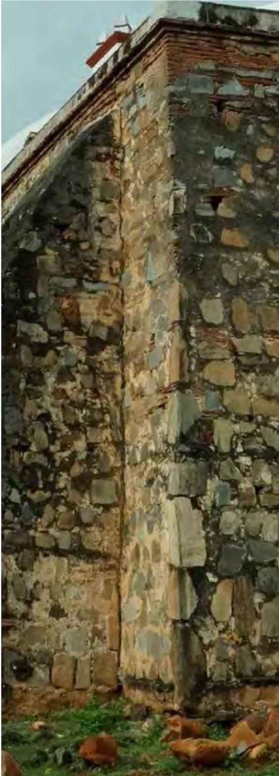
Fig. 24 Grieta entre el contrafuerte y el muro lateral del presbiterio. KFF, 2013
