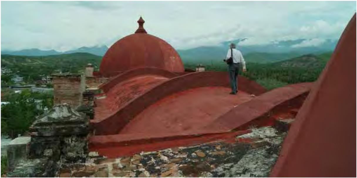
Fig. 104 Vista de la bóveda y la cúpula octogonal del coro. No hay pretil y se apresian los refrezcos de concreto. KFF, 2013
