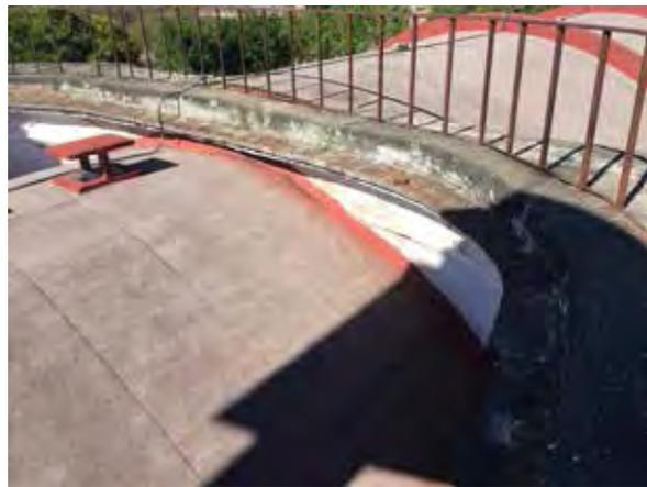
Fig. 96 Espacio que fue ocupado por una cúpula octogonal y sustituido por una bóveda de cañón corrido a mediados del siglo pasado, según información del fiscal. KFF, 2016.
