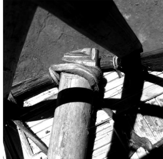
Fig. 60. Detalle donde puede observarse la unión entre la guarnición y el travesaño, hecho a partir de tiras de piel de venado. Fotografía tomada por el autor.
