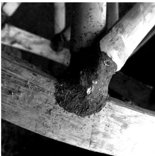
Fig. 56. Detalle de unión entre las estacas y la base, por medio de un amarre de *ixtle* y un pegamento vegetal a base de chautle. Fotografía tomada por el autor.
