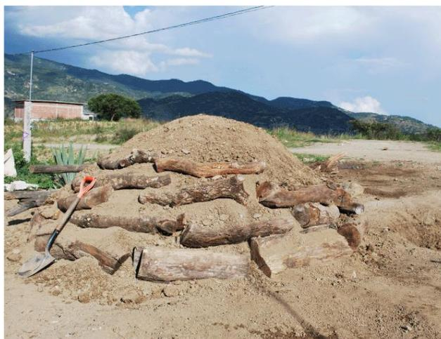
Figura 1.18 Horno completamente cubierto
