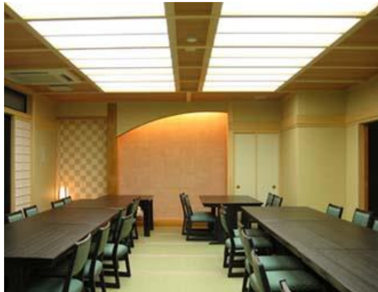
Figura I.15.- Panel o Plafón luminoso (Oficinas, s.f.)
