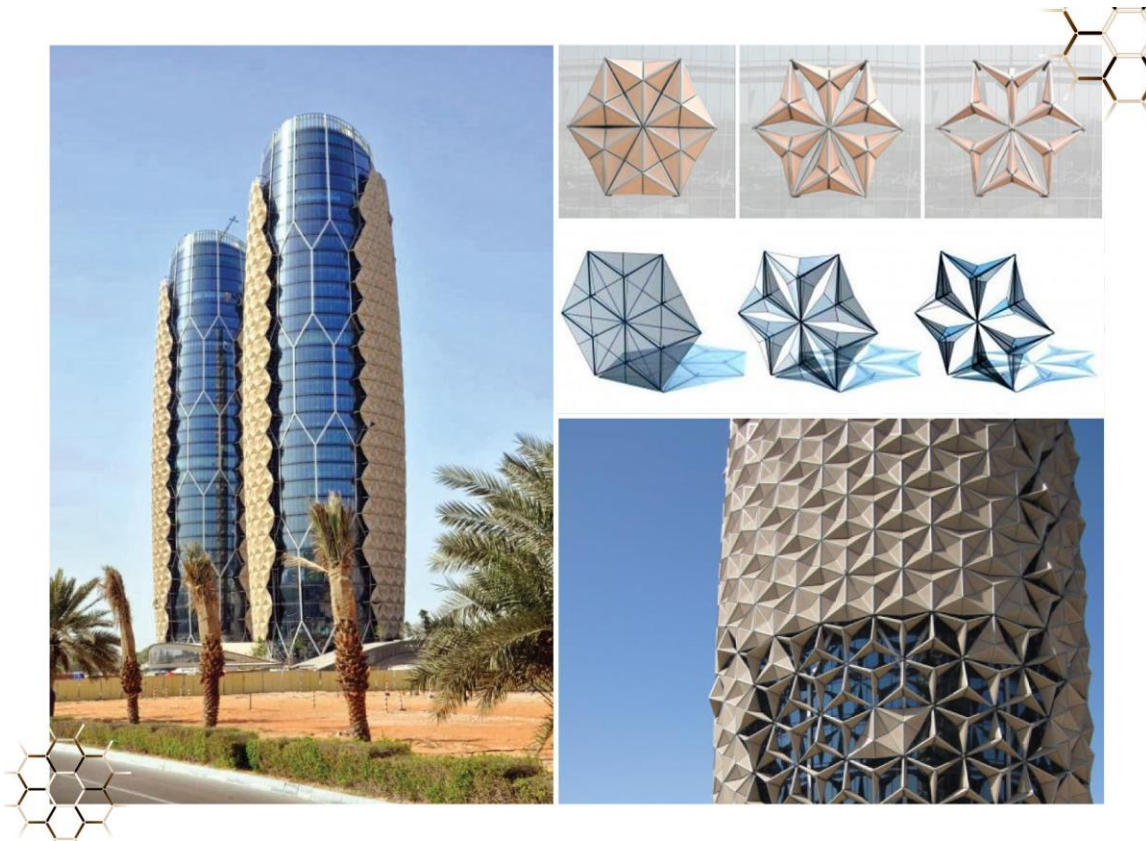
Al-Bahar Towers, Abu Dhabi, malla de protección solar modulada a base de hexágonos.
