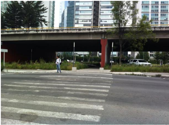
Paso peatonal por debajo de la autopista México-Marquesa.
