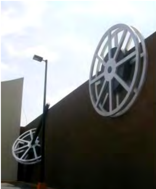
Barda Perimetral con detalles
