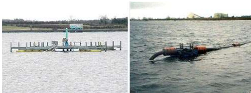
Figura 1.3.- Descarga subacuática de relaves ( www.tailings.info )
