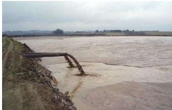
Figura1.4.- Punto único de descarga. (www.tailings.info).
