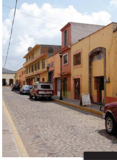
Alturas y vanos
