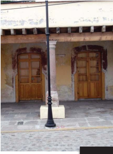
Portal en vivienda
