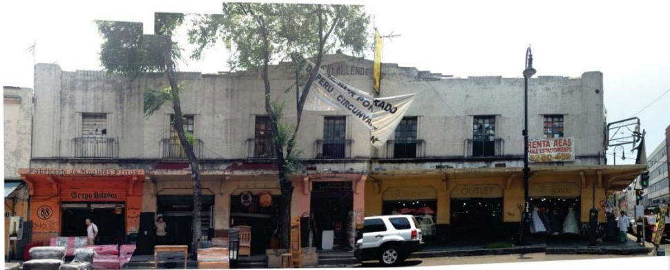
Fachada de Allende #88 (parte 1)
