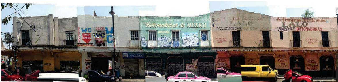
Fachada de Allende #88 (parte 2)
