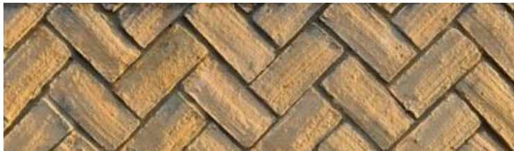
Muro de ladrillo, aparejo de espiga
