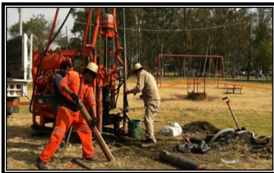
Figura 5. Sondeo geotécnico mixto con recuperación de muestra intacta (tubo Shelby) y de prueba de Resistencia a la Penetración Estándar (SPT) ó alterada, en la en la Ciudad de México (Tláhuac), realizado en Diciembre del 2014.
