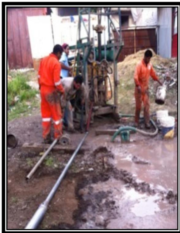
Figura 6. Sondeo geotécnico mixto con recuperación de muestra intacta y de la prueba de Resistencia a la Penetración Estándar (SPT) en la Ciudad de Irapuato, Guanajuato., realizado en Julio del 2015.
