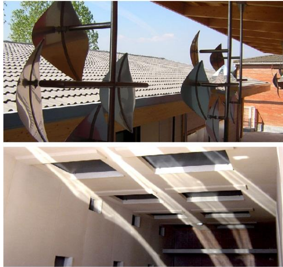
Ilustración 4-1 conjunto de reflectores dentro un rancho con habitaciones profundas
