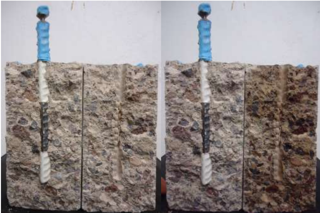
Figura 3.35.- Concreto con agregado natural carbonatado.
