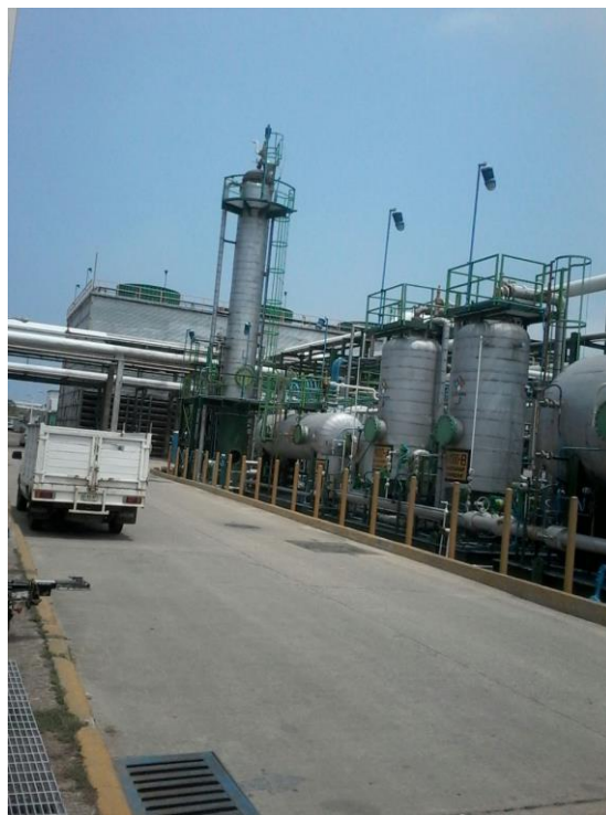
Ilustración 30: Ejemplo de espacio confinado, torres de proceso
