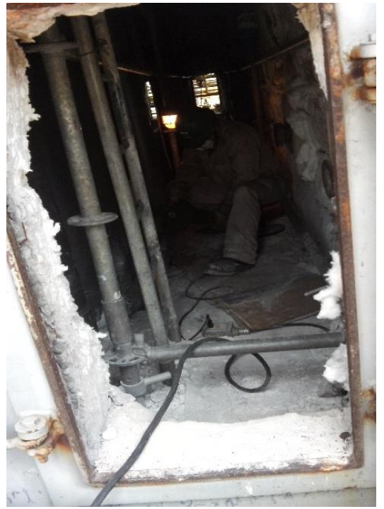
Ilustración 34: Ilustración 35: Esmerilado para soldar carrete soldadura.
