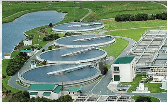
Ilustración 72. Planta de Tratamiento de Agua Residual
