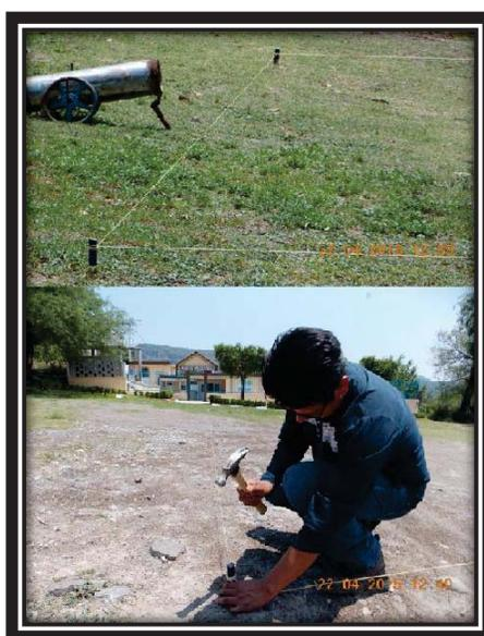
Figura 29. Marcación del terreno con hilo y estacas.
