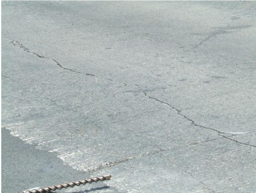
**Fotografía 6.** Fracturamiento de concreto hidráulico, debido a la subsidencia.
