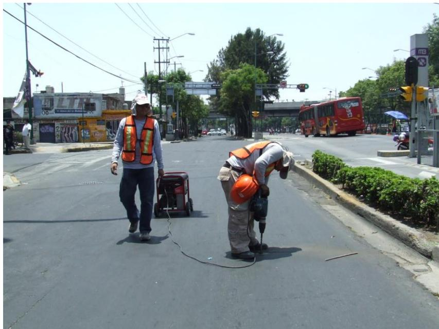
**Fotografía 4.** Perforaciones para inserción de electrodos.
