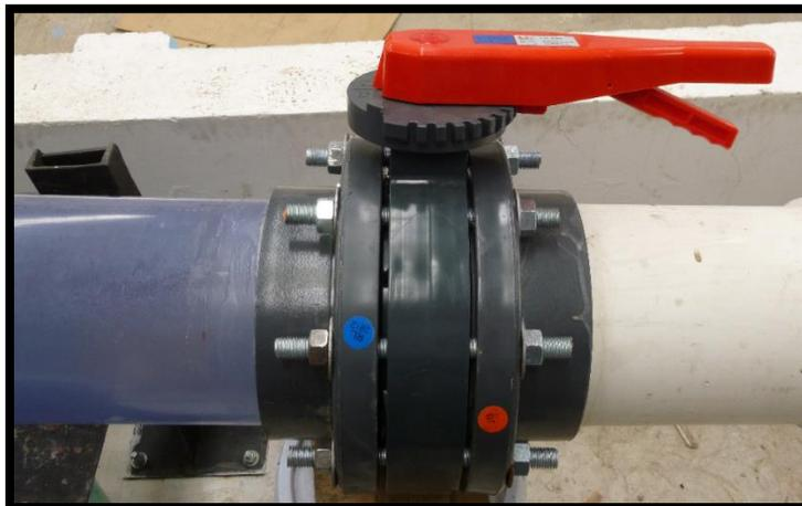
**Figura 4.7** Válvula de mariposa de 8 pulgadas.
