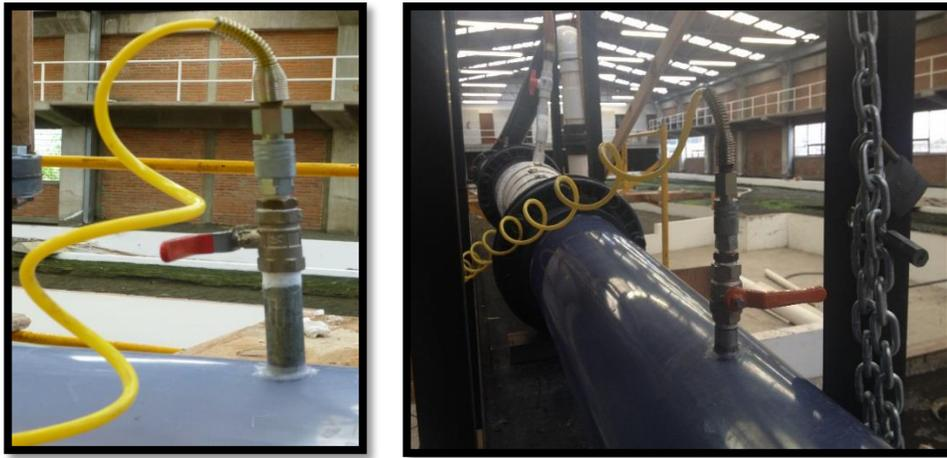
**Figura 4.6** Sistema de inyección de aire.
