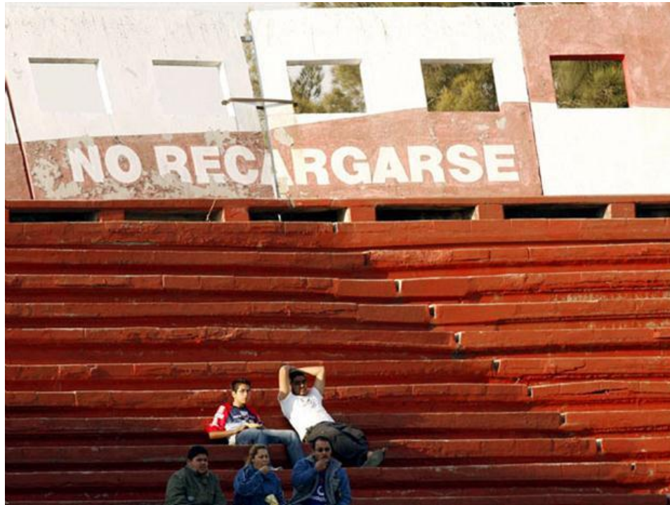
Fig. I-27 ESTADIO NEZA 86 ANTES DE LA REMODELACIÓN
