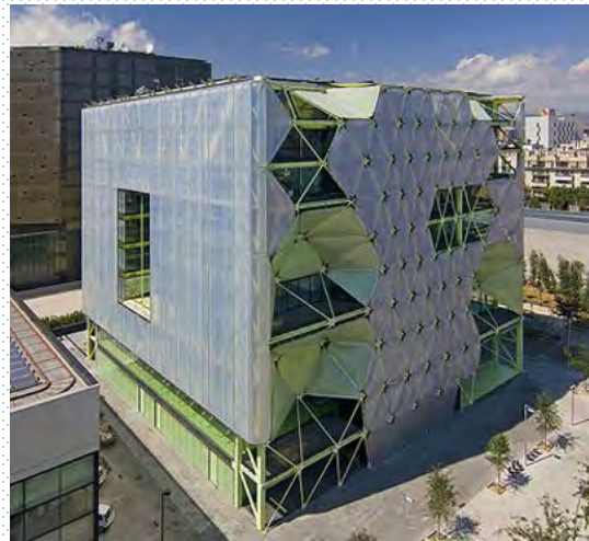
Imagen 8.10.6.A En la que se muestra la estructura plástica de un edificio.
