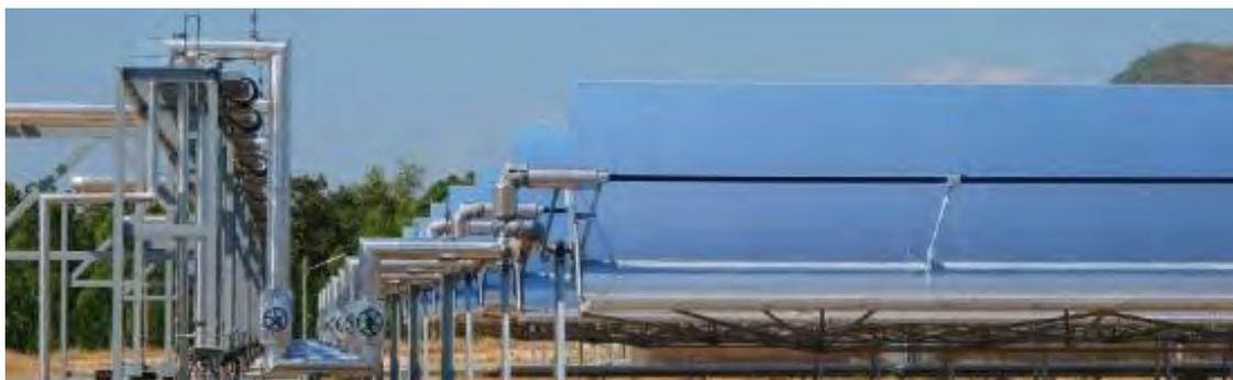
Fig. 1.11. Planta solar de 5 MW con generación directa de vapor en Tailandia.
