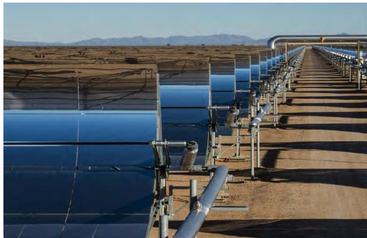
Fig. 1.8. Planta solar de Solana con una capacidad de 250 MW y 6 horas de almacenamiento por medio de aceite térmico.
