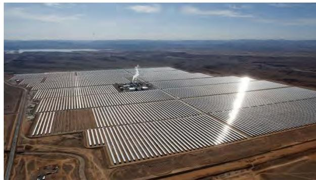
Fig. 1.10. Primera etapa del complejo solar Noor en Marruecos. 160 MW<sub>e</sub> a base de canales parabólicas con aceite térmico y capacidad de almacenamiento de tres horas
