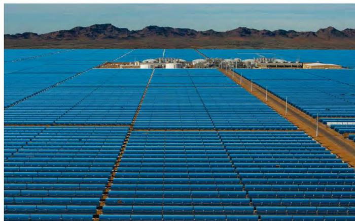
Fig. 1.9. Planta solar Solana de concentradores tipo canal parabólica con almacenamiento térmico, ocupando un área de 7.8 km<sup>2</sup> en el estado de Arizona, EE.UU. Instalada por Abengoa Solar.
