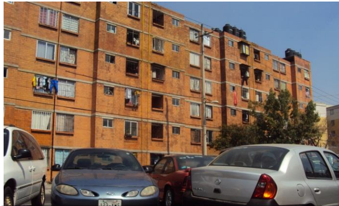
Possible crecimiento habitacional descontrolado
