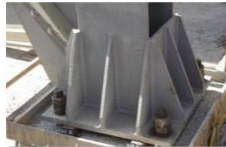
Imagen. Columna de acero y dado de cimentación. Fuente: cedex.es
