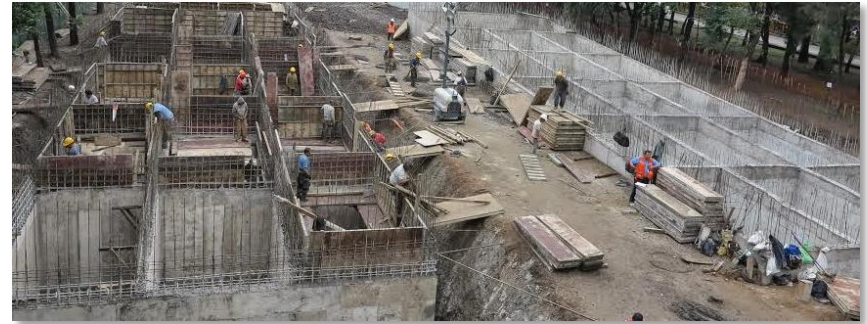
Imagen. Cajón de cimentación. Fuente: cedex.es
