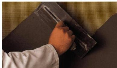
Las franjas de malla se aplican de abajo hacia arriba, haciendo un traslape de al menos 5 cm entre estas, hasta cubrir la totalidad del muro aislado.
