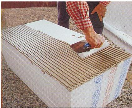
Ilustración 49 aplicación de basecoat con llana dentada
