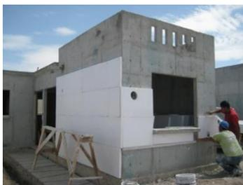
Dejar secar el Basecoat (2 a 3 horas, dependiendo del espesor y las condiciones ambientales) antes de aplicar la malla de refuerzo
