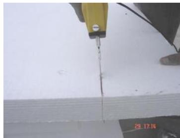
*Ilustración 46 Corte de placas de EPS*
