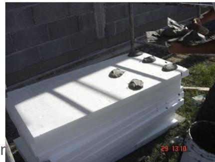
Ilustración 48 Aplicación de basecoat en montículos
