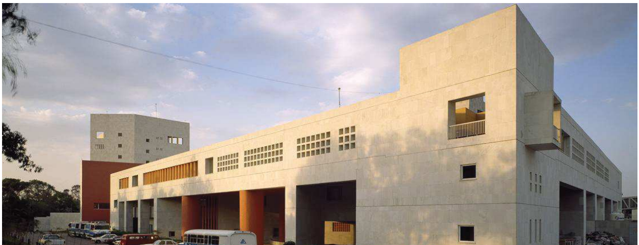
Vista exterior del Instituto Nacional de Rehabilitación. FUENTE: http://www.arquinteg.com.mx/portfolio/
