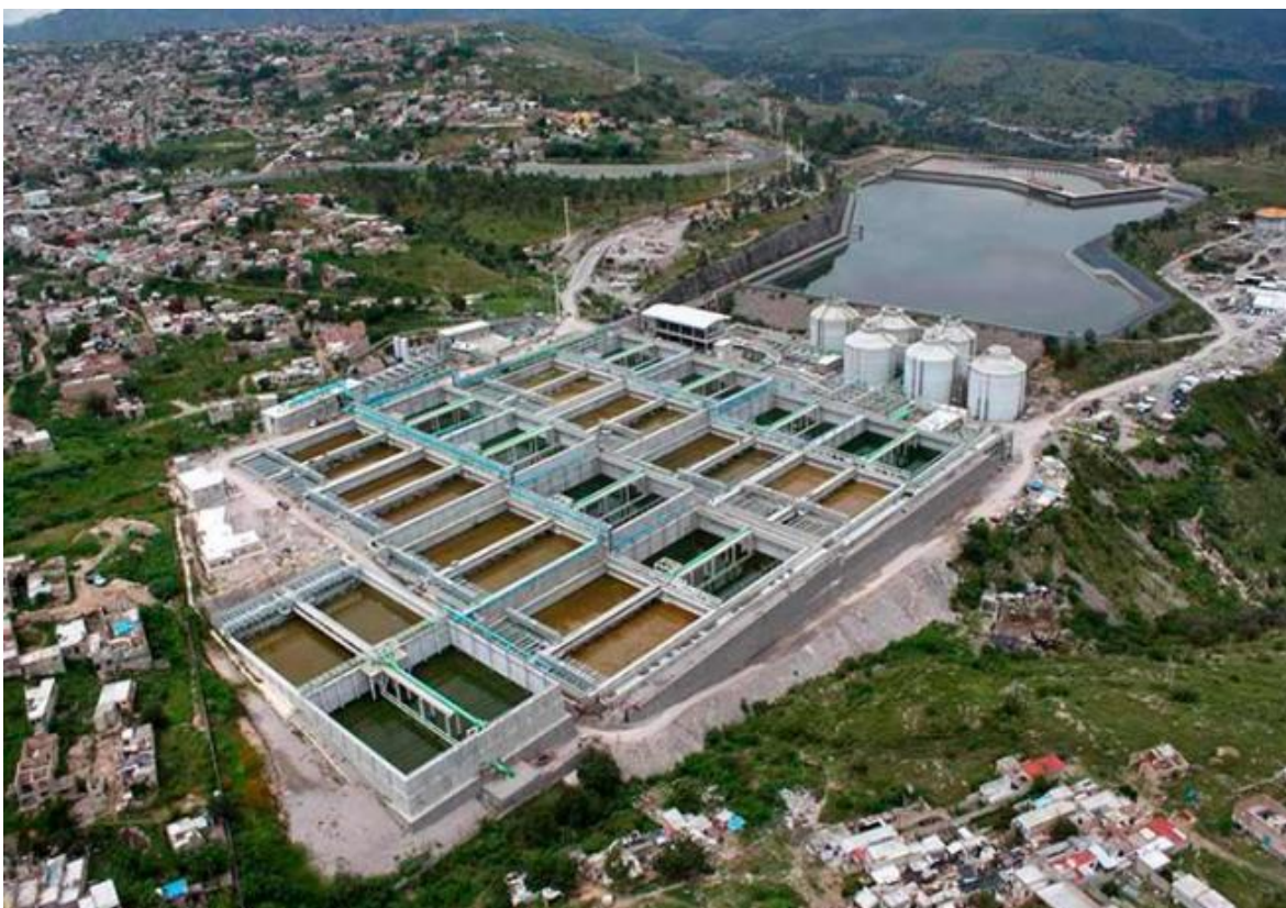
Figura 58: Planta terminada de la PTAR Agua Prieta.
