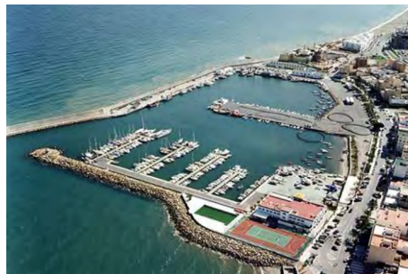
Figura 3 Protección contra el oleaje
