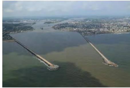
Figura 4 Estabilización de canales
