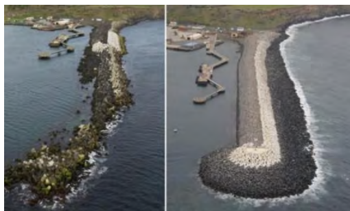
Figura 11 Falla por acumulación de daños
