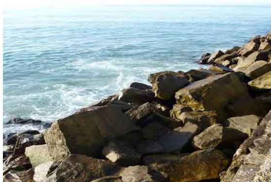
Figura 17 Estructura de enrocamiento
