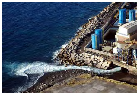
Figura 5 Protección de desalinizadora
