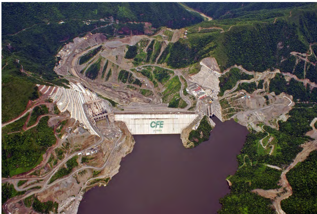
Figura 4.1 Central Hidroeléctrica La Yesca
